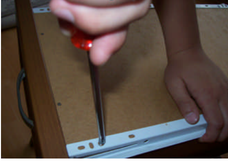
Resim 2.12: Çekmece rayının çekmeceye montajı
