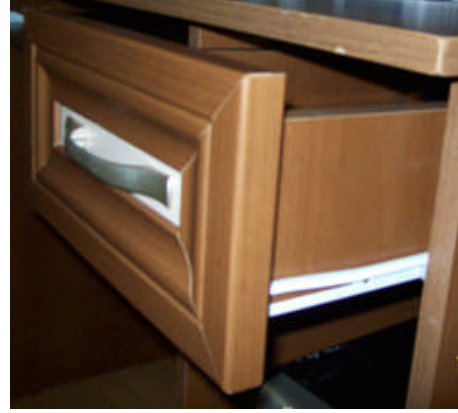
Resim 2.21: Çekmecenin gövdeye montajı
