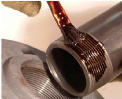
Resim 3.13: Sıvı conta sürülmesi
