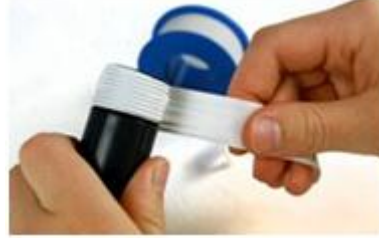
Resim 3.12: Teflon bant sarılması
