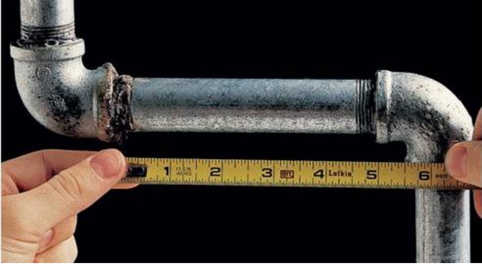
Resim 1.6: Borularda ölçü alma
