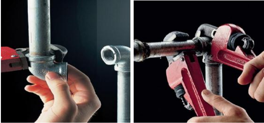
Resim 3.1: Bağlantı parçası sıkma
