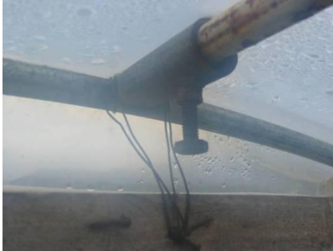
Resim 2.8: Üst omurganın tutturulması
