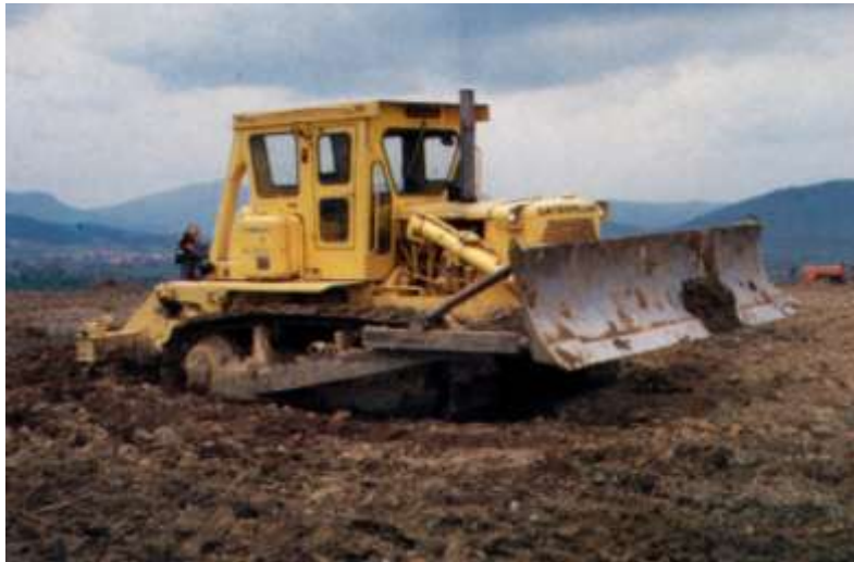
Resim 3.1: Arazide toprak tesviye işlemi
