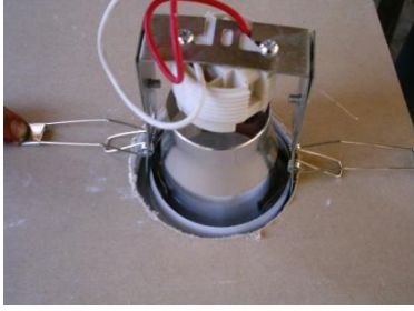
Resim 3.11: Armatürün yerleştirilmesi
