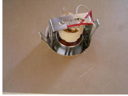
Resim 3.11: Armatürün yerleştirilmesi
