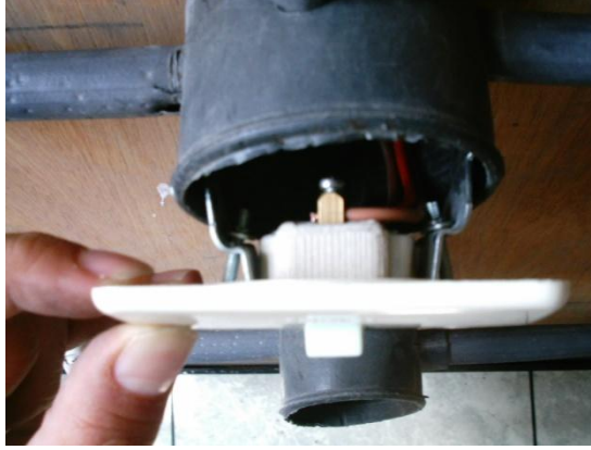
Resim 2.13: Lihtin kasaya yerleřtirilmesi
