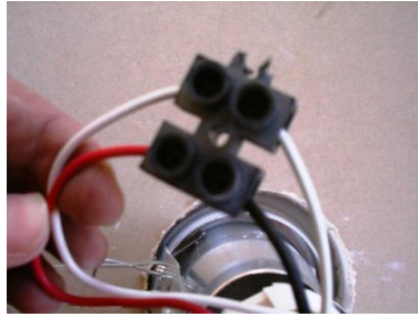
Resim 3.15: Armatüre nötr kablosunun bağlanması
