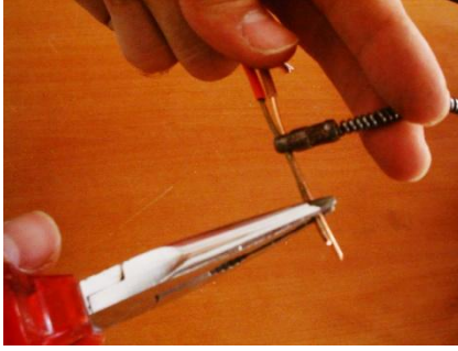
Resim 2.11: Kablonun kılavuza tutturulması
