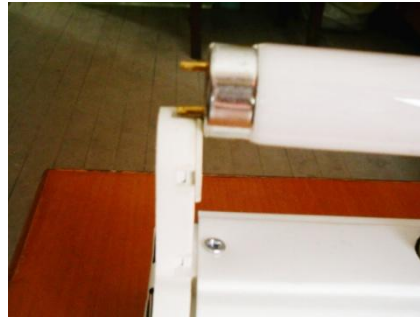
Resim 4.26: Floresan ampulün sokete takılması
