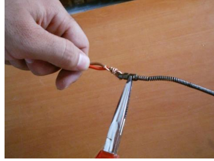
Resim 2.11: Kablonun kılavuza tutturulması
