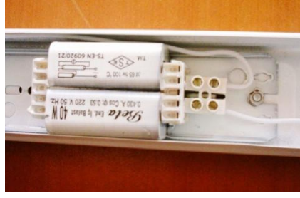
Resim 4.18: Balastın diğ er ucunun baėlantısı
