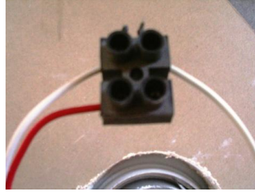
Resim 3.14: Armatürün bir ucuna bağlantı
