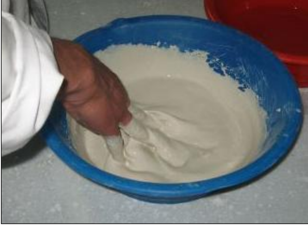
Resim 2.2: Astarın karıştırılarak hazırlanması
