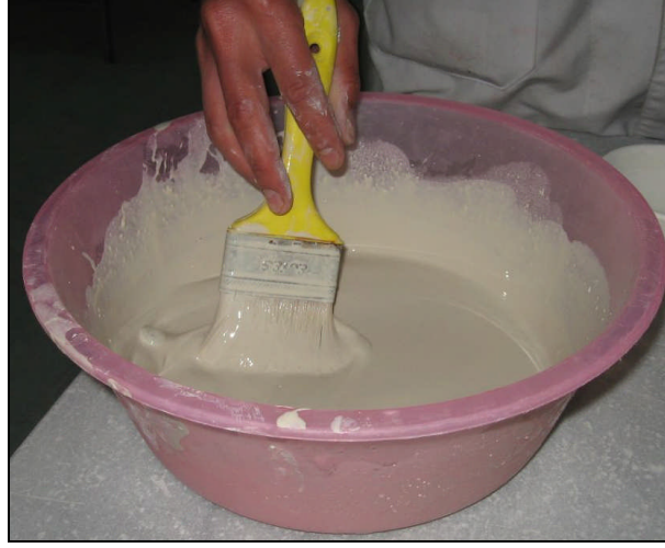
Resim 2.3: Fırçanın uç kısmının astar içerisine batırılması
