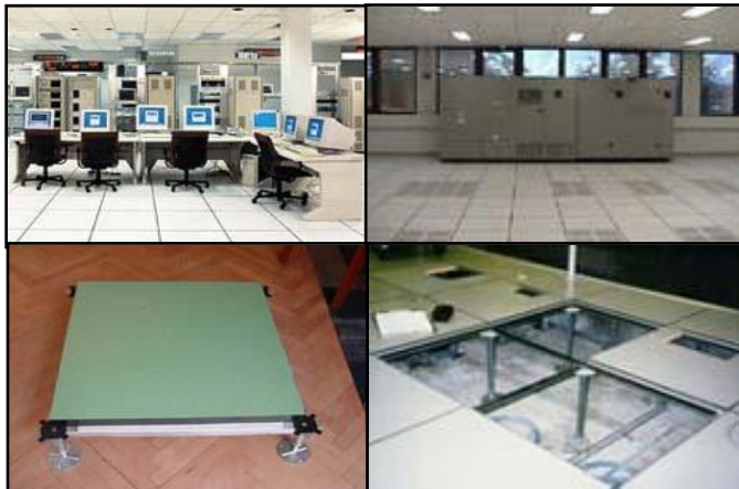
Resim 2.1: Yerden döşeme kanal ve borular
