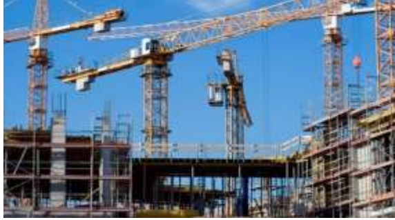
Fotoğraf 1.4: Kaldırma aracı - kule vinç
