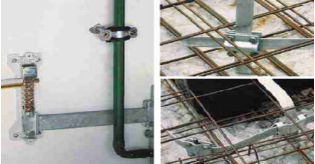
Resim 3.4: Yapılmış topraklama örnekleri
