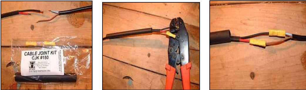
Resim 1.10: Ek yapılmış ve yalıtılmış kablo
