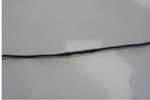
Resim 1.27: İzole bandın iletkenin üzerine sarılması
