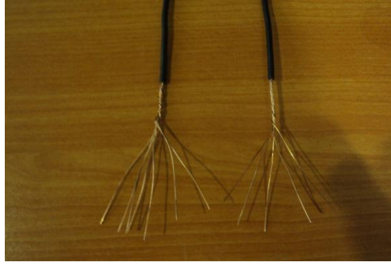
Resim 1.20: Çok damarlı iletkenlerin soyulması
