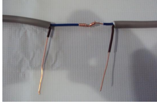
Resim 2.4: Birinci damarın 90°lik açı ile çapraz tutulması ve birbirinin üzerine sarılması
