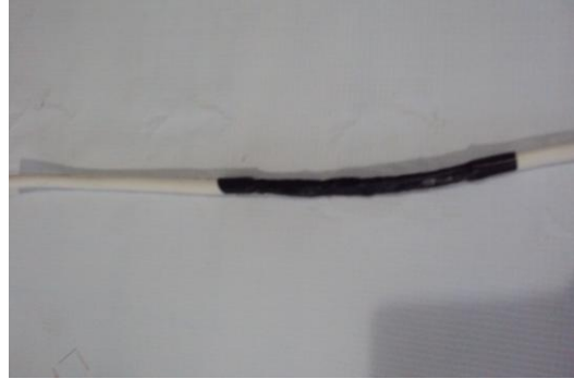
Resim 2.21: Çok telli iletkenlerde çift düz ekin yalıtılması
