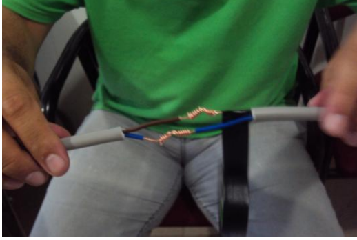
Resim 2.16: Çift düz ekte birinci damarın yalıtılması
