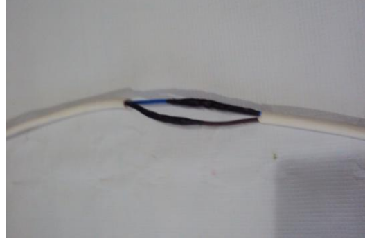
Resim 2.20: Çok telli iletkenlerde çift düz ekte ikinci damarın yalıtılması
