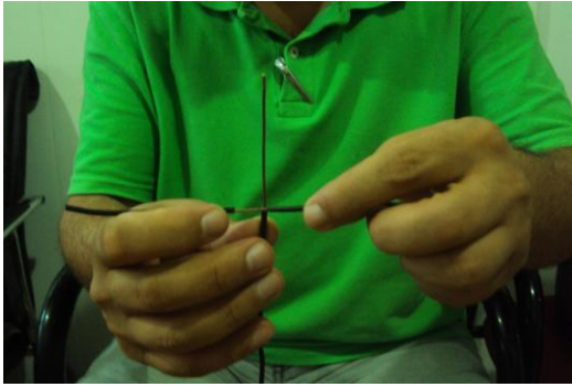
Resim 2.11: İletkenin dik tutulması ve sarılma işlemi
