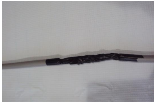
Resim 2.18: Çift düz ekin yalıtılması
