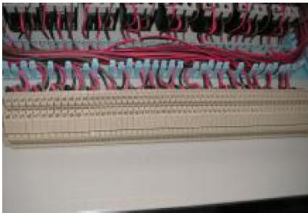
Resim 3.7: İletkenlerin klemenslere yerleştirilmesi
