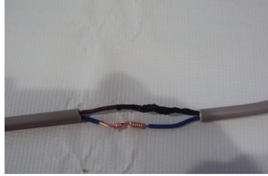
Resim 2.16: Çift düz ekte birinci damarın yalıtılması
