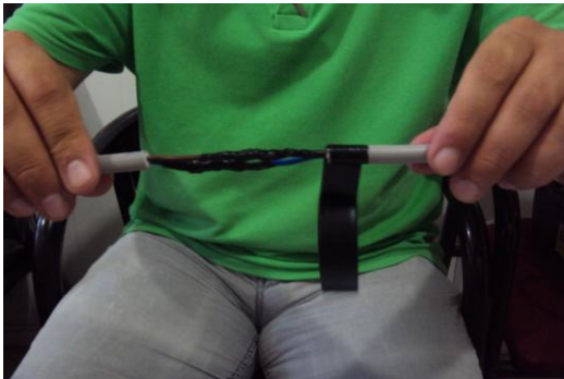
Resim 2.18: Çift düz ekin yalıtılması
