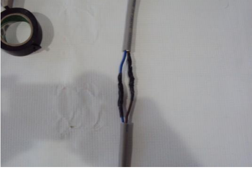
Resim 2.20: Çok telli iletkenlerde çift düz ekte ikinci damarın yalıtılması
