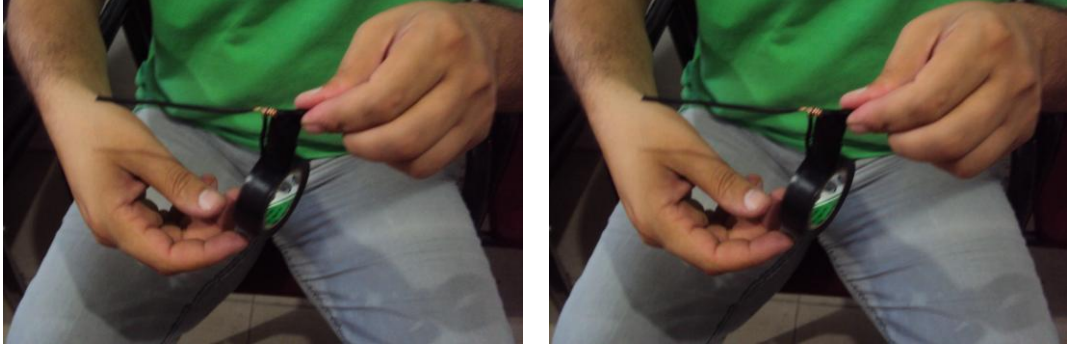
Resim 2.22: T- ekin üzerine izole bandın sarılması
