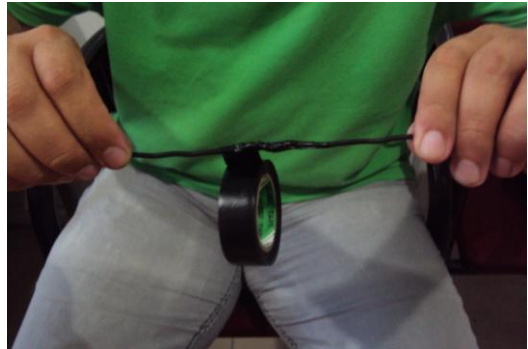
Resim 1.24: İzole bandın iletkenin üzerine sarılması
