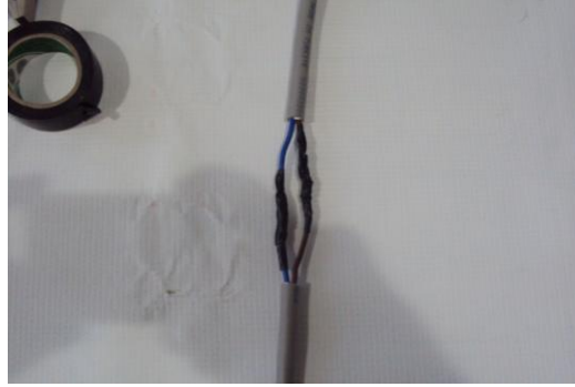
Resim 2.17: Çift düz ekte ikinci damarın yalıtılması
