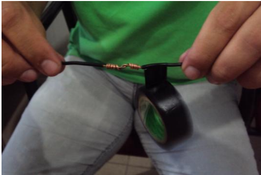
Resim 1.24: İzole bandın iletkenin üzerine sarılması
