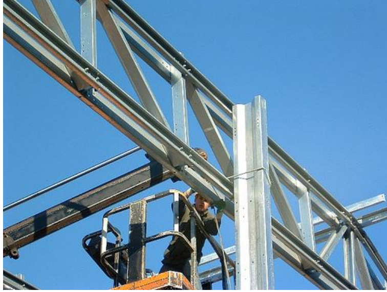
Resim 1.23: Cıvatalı birleştirilen çelik konstrüksiyon
