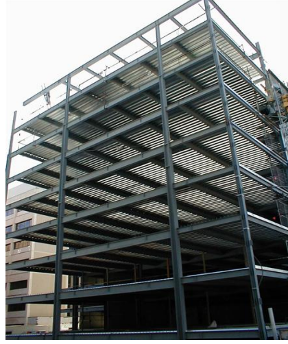
Resim 1.1: Çok katlı çelik yapı
