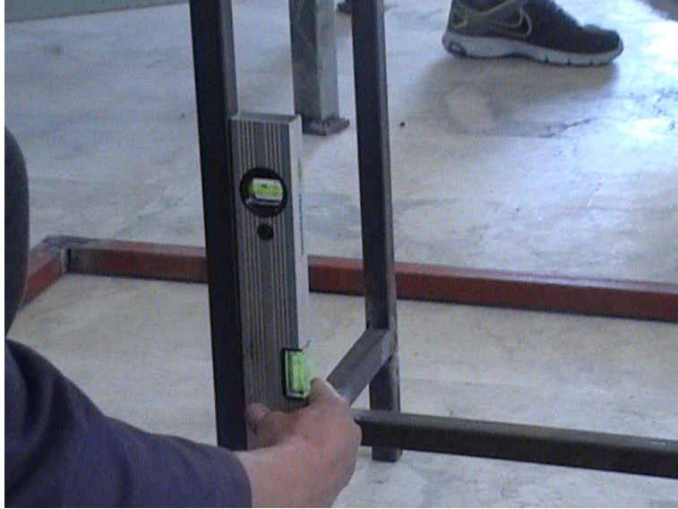
Resim 2.5: Su terazisi ile diklik kontrolü
