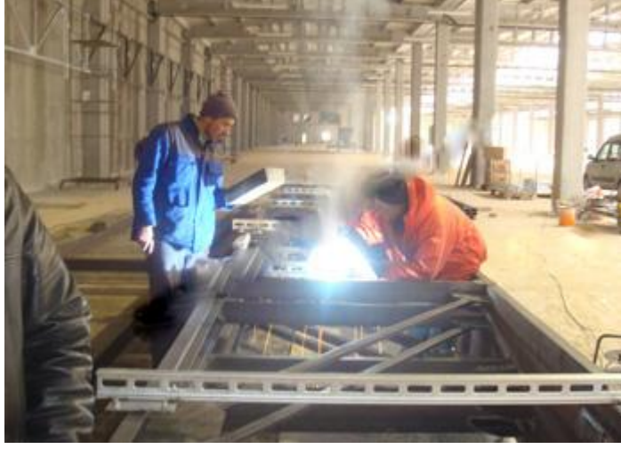
Resim 1.5: Serbest zeminde çatı makasının kaynakla montajı
