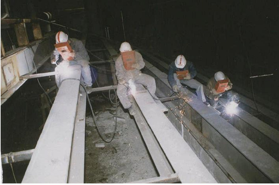
Resim 2.13: Kaynaklı grup montajı
