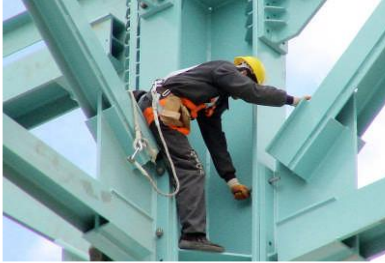
Resim 2.15: Civatanın takılması
