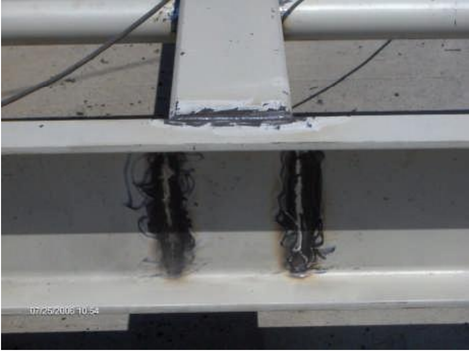
Resim 2.16: Grupların kaynaklı birleştirilmesi
