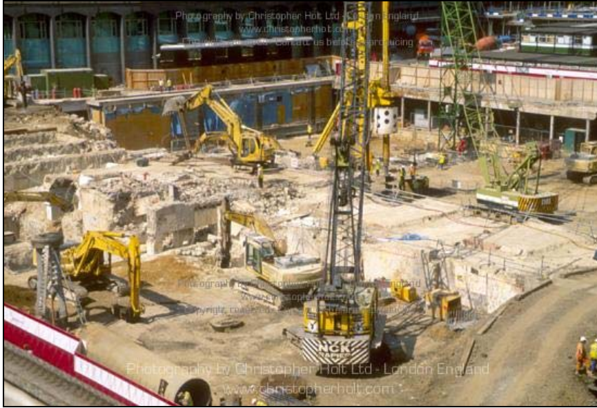
Resim 5: Şantiyeden bir görünüm
