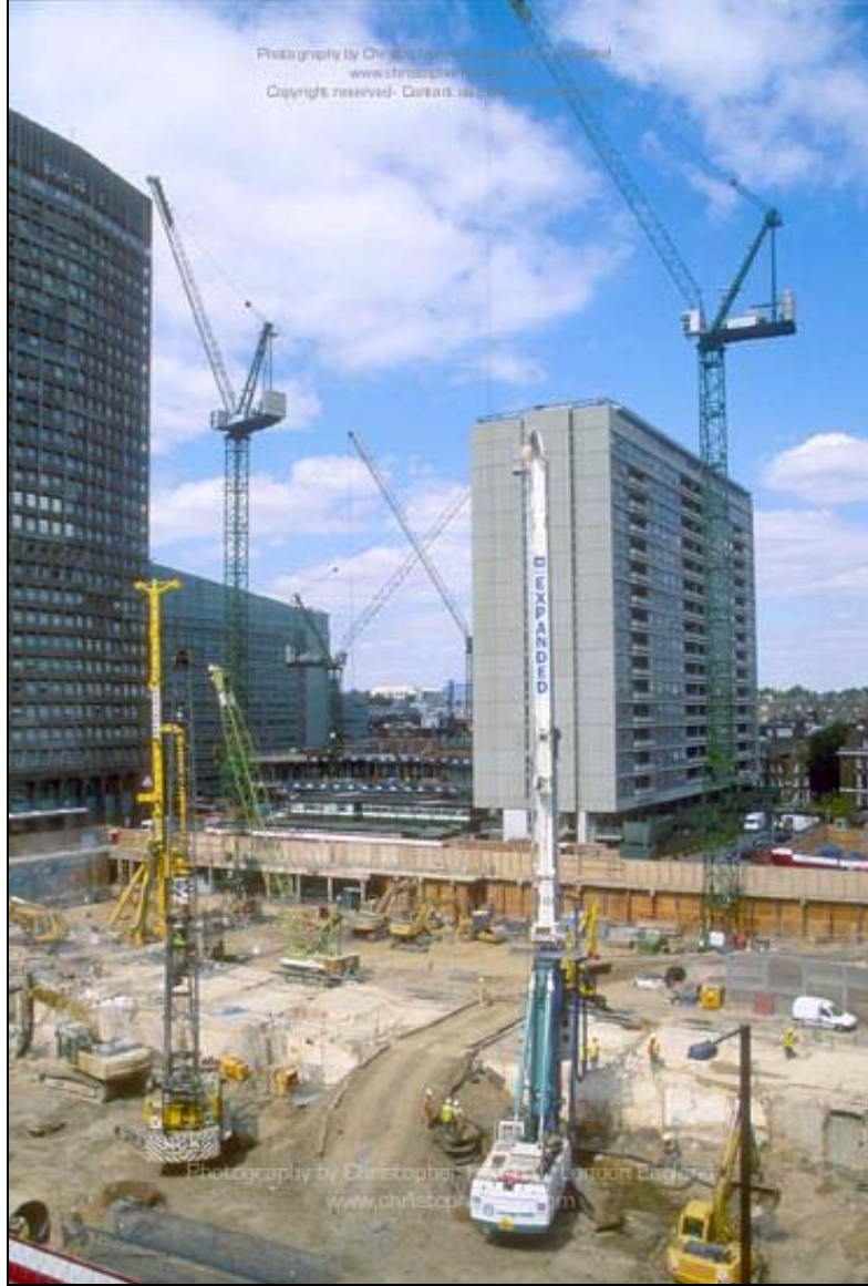
Resim: 2 Şantiyeden bir görünüm
