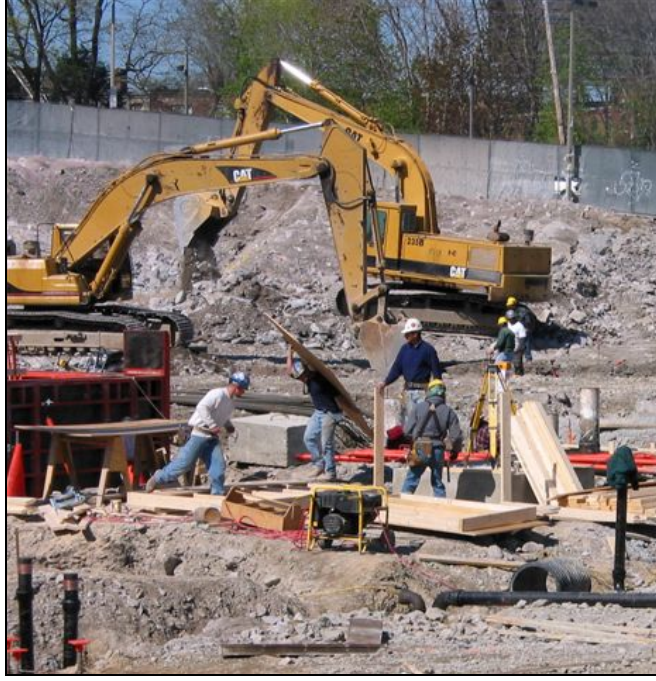
Resim 1: Şantiyeden bir görünüm
