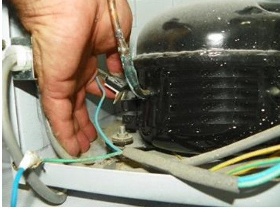
Resim 1.6: Arızalı termiğin sökülmesi
