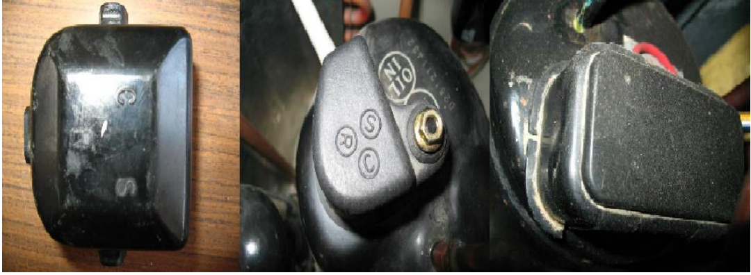
Resim 1.13: Farklı kompresör terminalleri kapakları
