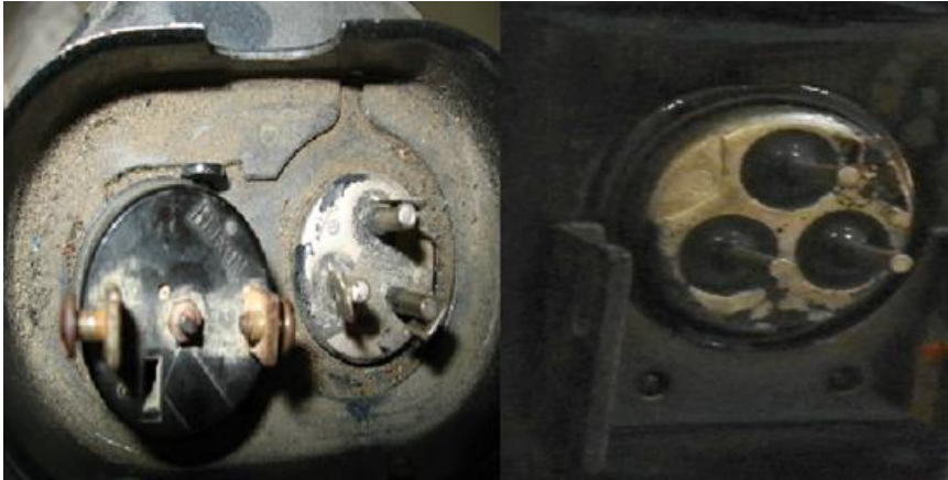
Resim 1.12: Farklı kompresör terminalleri (füzit uçları)
