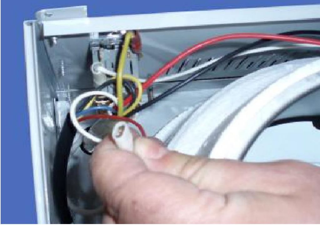
Resim 1.23: Şerbetlik /su sebiline termostat elektrik bağlantısının sökülmesi
