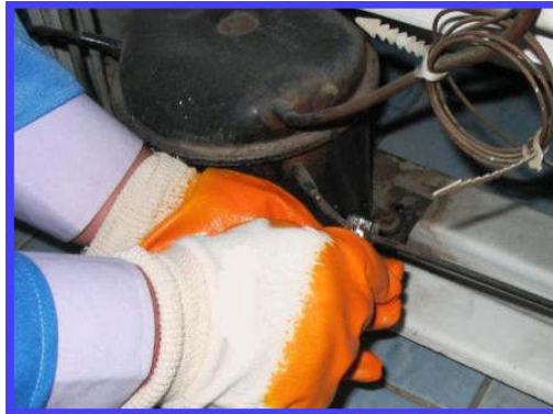
Resim 2.13: Kompresör bağlantı borularının kesilmesi
