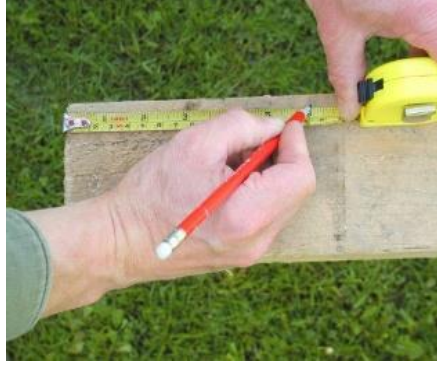
Fotoğraf 2.14. Şerit metre ile ölçü işaretleme
