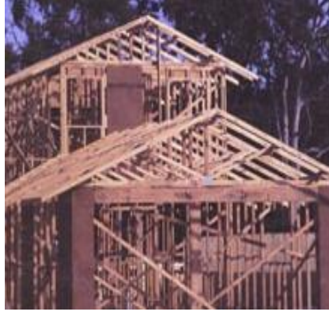
Resim -5: Ahşap ev iskeleti
