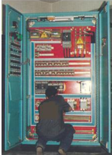
Resim 3.4: Kumanda panosu son kontrollerini yapan teknisyen
