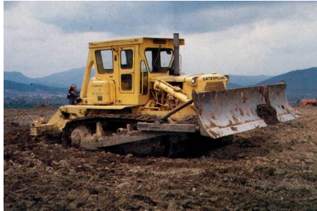
Resim 2.1: Arazide toprak tesviye işlemi
