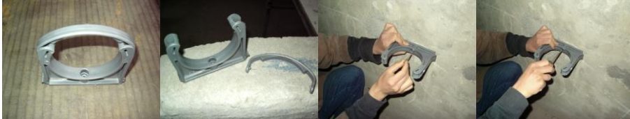
Resim 1.4: Plastik kelepçenin duvara sabitlenmesi
