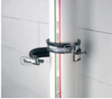
Resim 1.6: PVC borunun metal kelepçe ile sabitlenmesi
