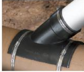
Resim 5.2: Bina atık su kanalizasyon bağlantısı
