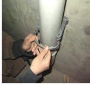
Resim 1.5: PVC borunun plastik kelepçe ile sabitlenmesi
