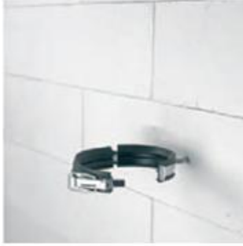
Resim 1.5: PVC boru için metal kelepçenin duvara montajı
