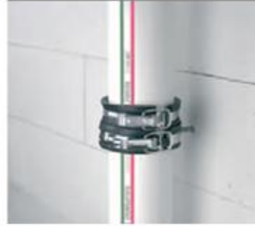
Resim 1.6: PVC borunun metal kelepçe ile sabitlenmesi
