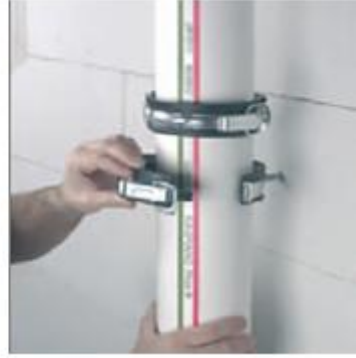
Resim 1.5: PVC boru için metal kelepçenin duvara montajı
