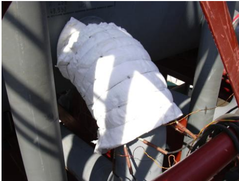
3. Isıtıcının izole dilmesi
