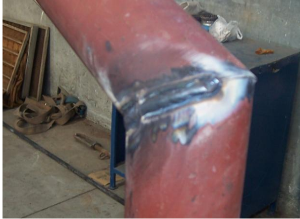
Resim 4.4: L dirseğin kaynatılması
