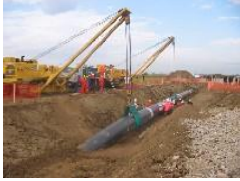
Resim 1.4: Petrol boru hattı montajı
