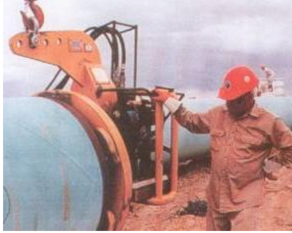
Resim 1.13: Boruların ağızlamasında kullanılan makine
