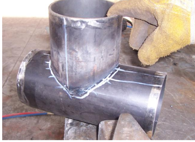
Resim 3.4: Arakesit çıkararak alıştırılan boruların puntalanması
