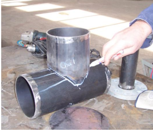
Resim 3.2: Arakesit markalama
