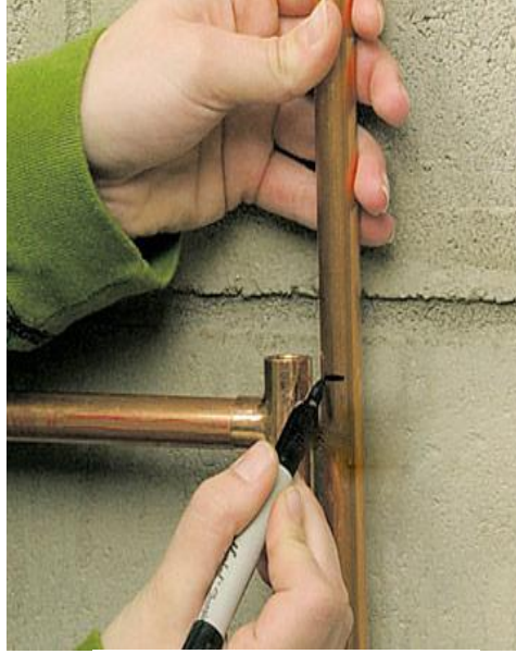
Resim1.4: Boru ölçü alımı
