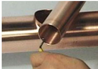
Resim 1.21: Boru ağızları raybalanır
