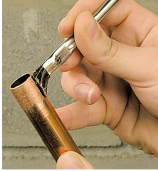
Resim1.7: Temizlenen yüze dekapan sürülmesi
