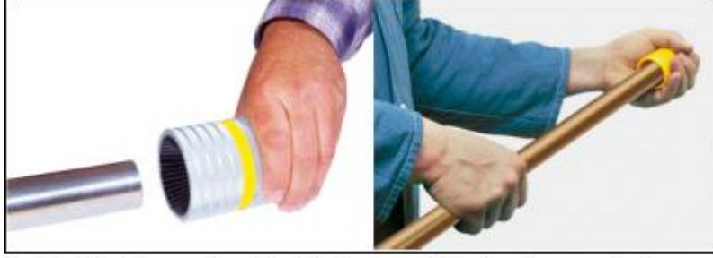
Resim 2.2 : Boru raybası ile alüminyum ve bakır boruların raybalanması
