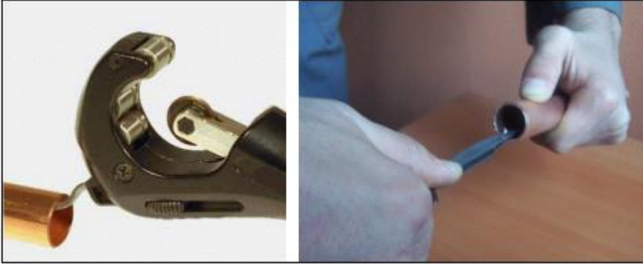
Resim 2.5 : Boru keski raybası ve çakı ile çapak alınması
