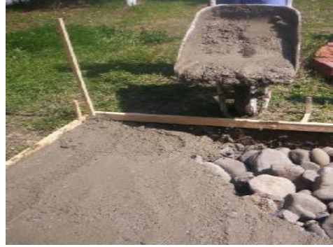
Resim 30: Beton Dökme İşlemi
