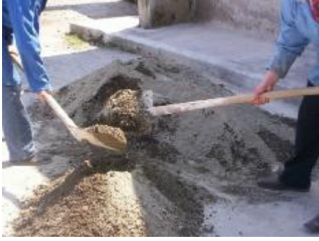
Resim 21: Beton Harcının Kuru Karıştırılması
