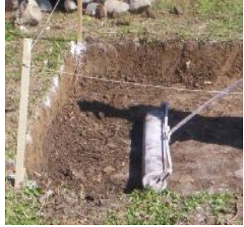
Resim 7- Zeminin Silindirle Sıkıştırılması
