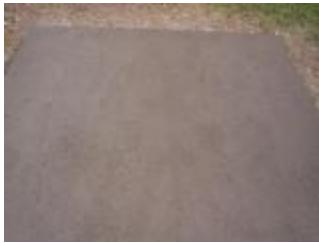
Resim 36: Perdahı Bitmiş Beton Yüzeyi
