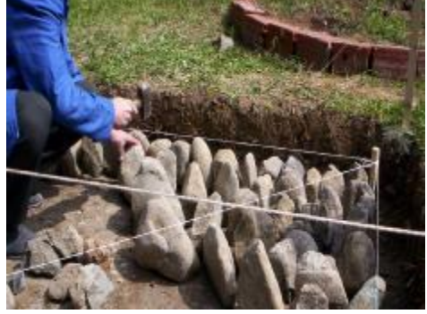
Resim 12- İp İstikametinde Blokaj Taşlarının Döşenmesi
