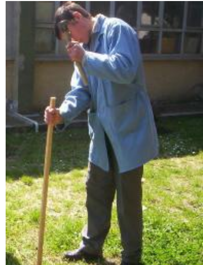
Resim 2: Köşe kazıklarının Çakılması
