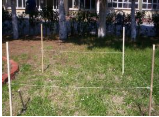
Resim 4: Köşe kazıkları Üzerine İp Aplikasyonunun yapılması
