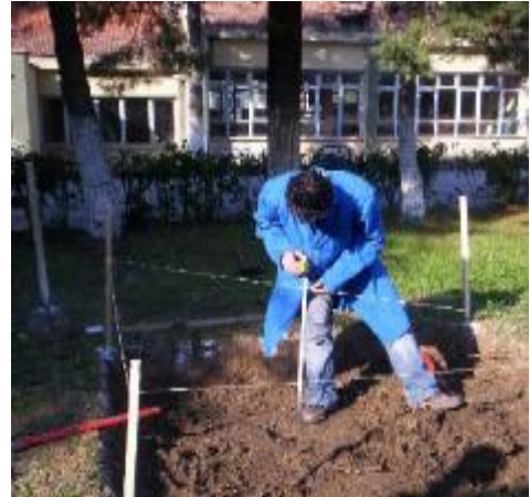
Resim 8- Tesviye Kazısının Düzgünlük Kontrolü
