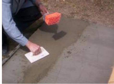
Resim 34: Beton Yüzeyinde Tirfilin Kullanılması
