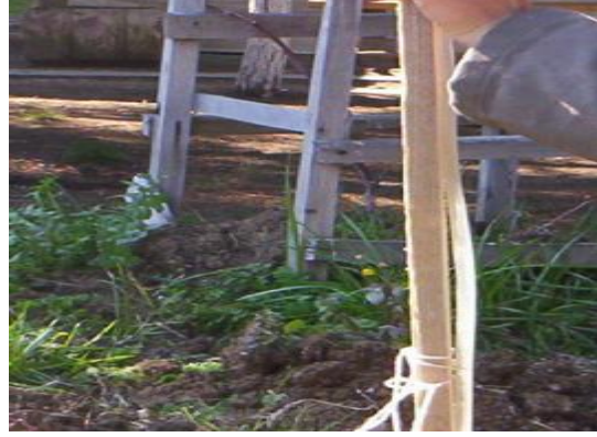
Resim 3: Kazı Yüksekliğinin Kazıklar Üzerine İşaretlenmesi
