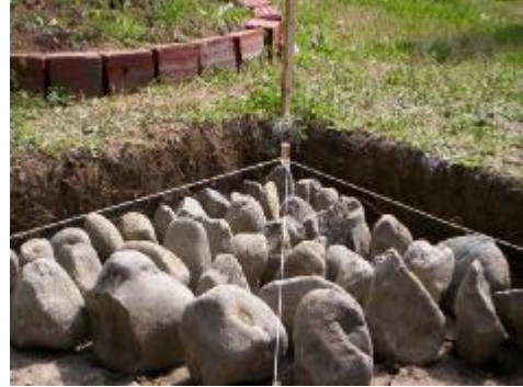
Resim 14- Köşegen İpleri ile Düzgünlük Kontrolü
