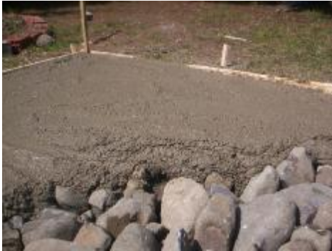
Resim 28: Beton Üst Yüzeyinin Masterlanması ( Kalıba Alınması )
