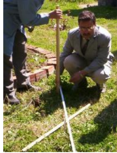
Resim 1: Köşe Kazıklarının Yerinin Belirlenmesi
