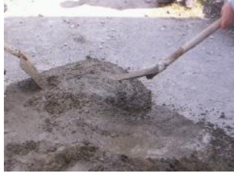
Resim 22: Beton Harcının Yaş Karıştırılması
