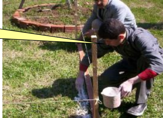
Resim 5 Kazı Yapılacak Alanın İşaretlenmesi
