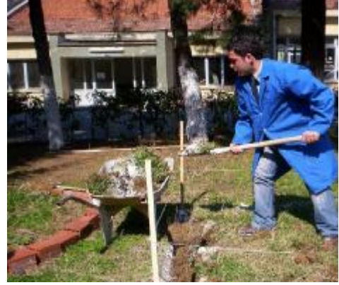
Resim 6- Tesviye Kazısının Yapılması ve Toprağın Atılması
