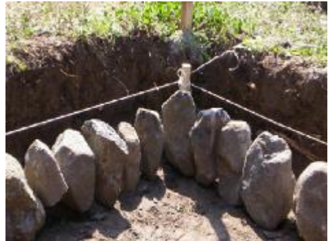
Resim 11- İp İstikametinde Blokaj Taşlarının Döşenmesi
