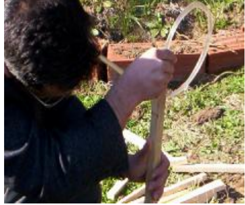
Resim 10- Blokaj Yüksekliğinin Hortumlu Su Düzeci İle Diğer Kazıklara Taşınması
