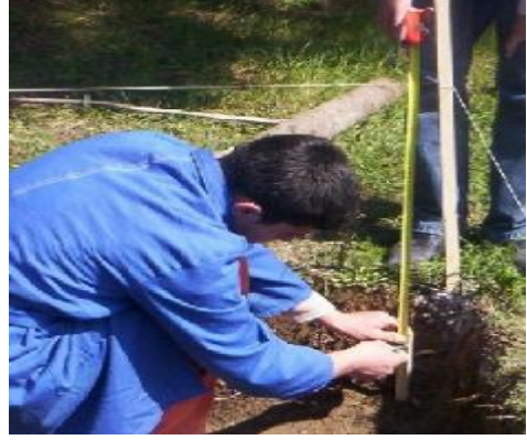
Resim 9- Blokaj Yüksekliğinin Kazığa İşaretlenmesi
