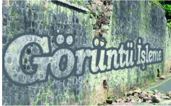
Şekil 4.33: Duvar üzerine yazı eğiminin verilmesi
