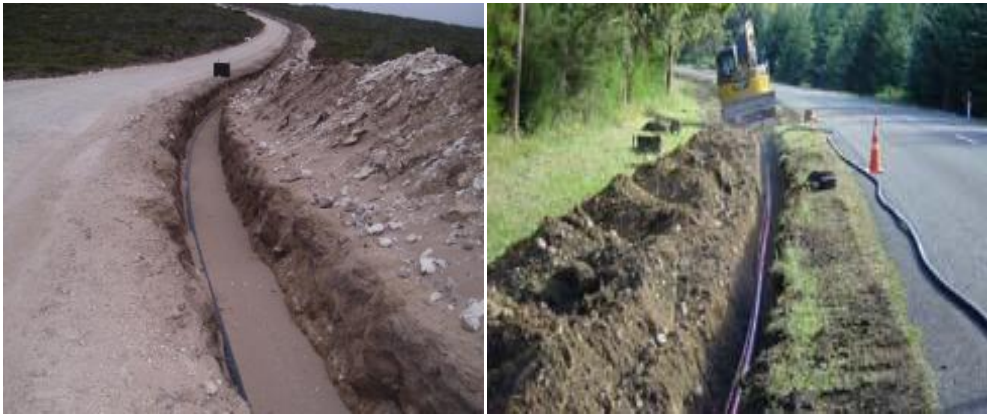
Resim 2.11: Kanala kum döşenmesi ve kablunun yerleştirilmesi
