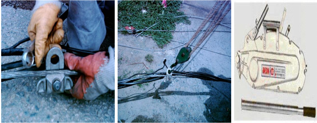
Resim 1.32: Askı halatının iletkene bağlanması, çekilmesi ve trifor
