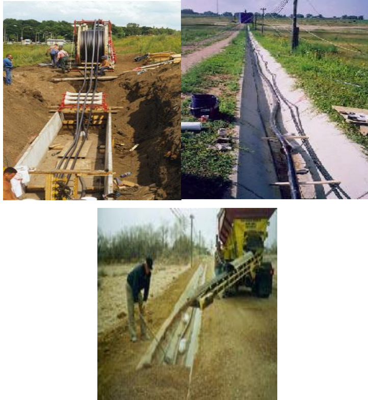
Resim 2.15: Kabloların beton kanallara dőşenmesi ve kanalın kapatılması
