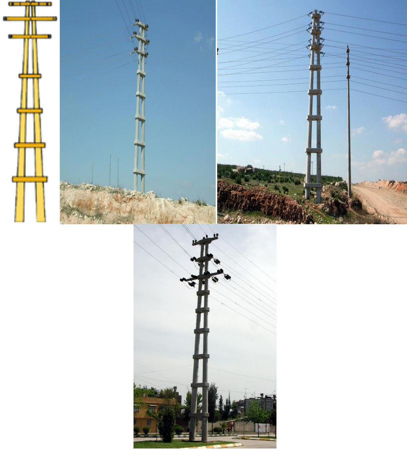
Resim 1.9: Çift santrifüj beton direkler
