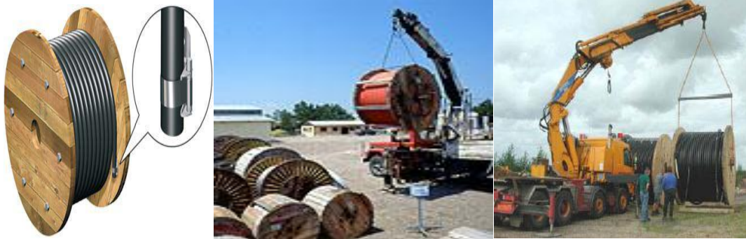
Resim 2.2: Kablo makarası ve indirilmesi
