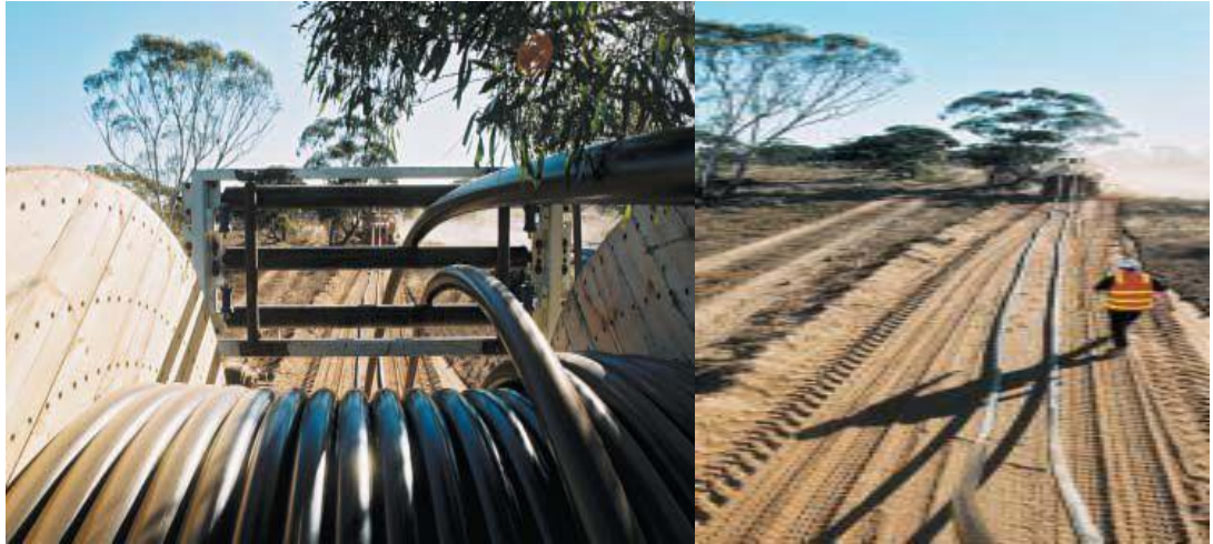
Resim 2.5: Kablonun serilmesi
