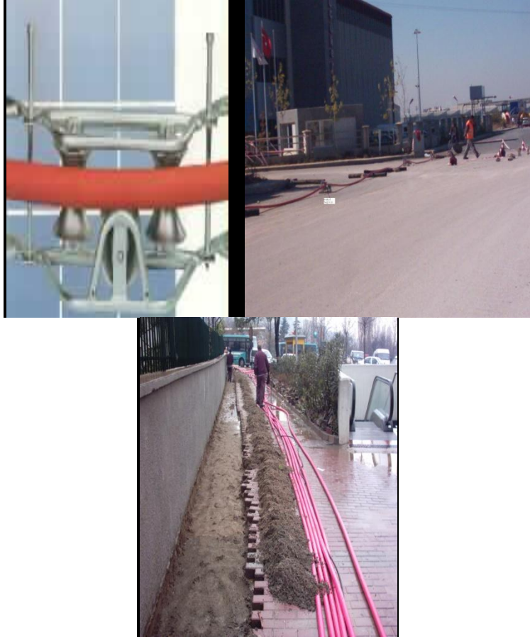
Resim 2.6: Kablo taşıyıcı ve kablo serilmesi
