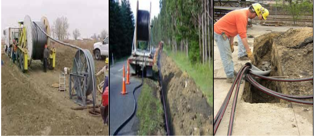
Resim 2.12: Kanala kablonun döşenmesi
