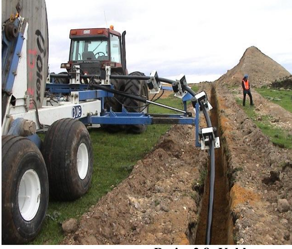
Resim 2.8: Kablonun serilmeden döşenmesi
