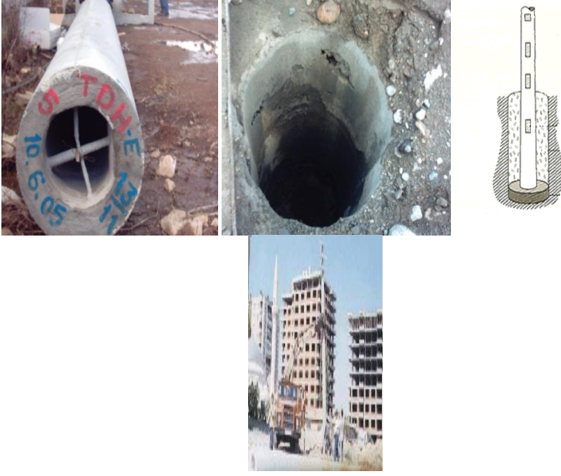
Resim 1.11: Santrifüj direk (SBA) ve temeli, vibre direk temeli ve dikilmesi
