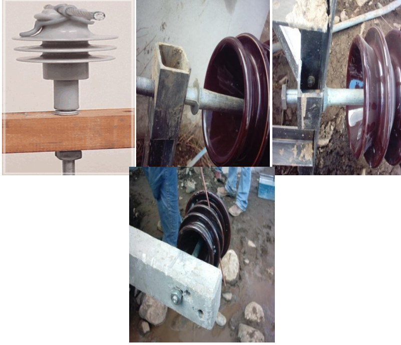
Resim 1.22: Mesnet tipi izolatörlerin montajı
