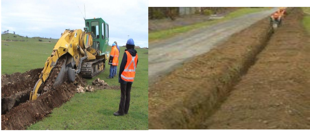
Resim 2.10: Toprak zeminde kablo kanalı açma
