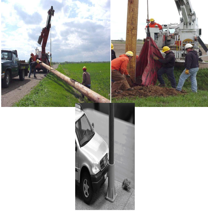
Resim 1.13: Ağaç direklerin dikilmesi ve koruyucu direk
