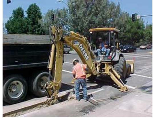
Resim 2.9: Sert zeminde kablo kanalı açma
