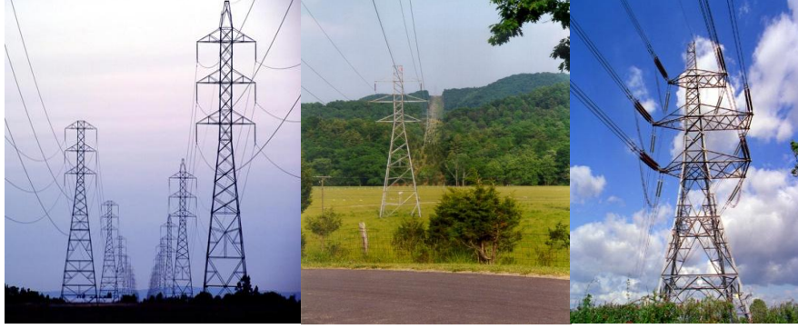
Resim 1.1: Pilon tipi demir direkler
