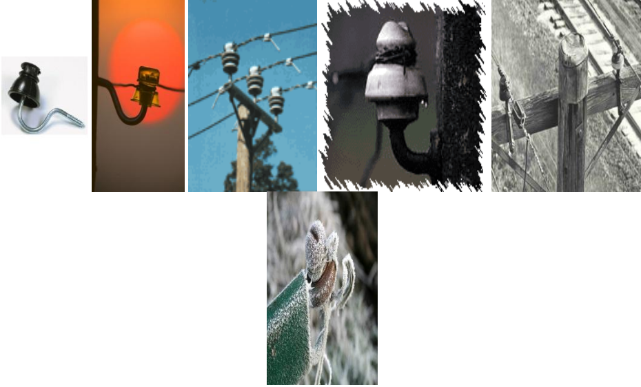
Resim 1.24: Fincan tipi (N60- 80- 95 ) mesnet izolatörlerin montajı
