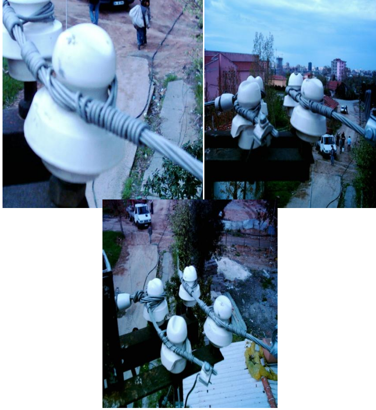
Resim 1.34: İletkenlerin izolatöre bağlanması
