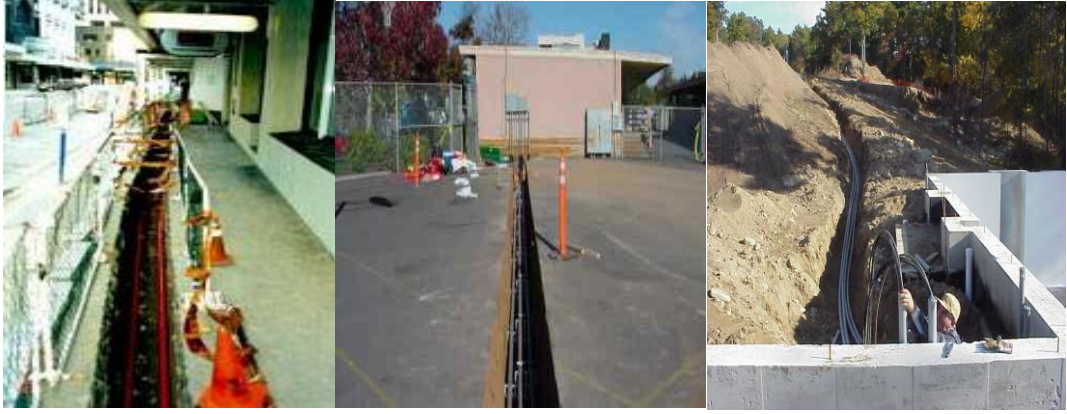
Resim 2.14: Kablonun deęişik tipte kanallara dőşenmesi
