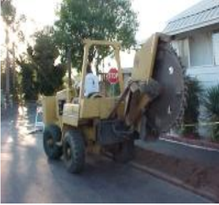
Resim 2.9: Sert zeminde kablo kanalı açma
