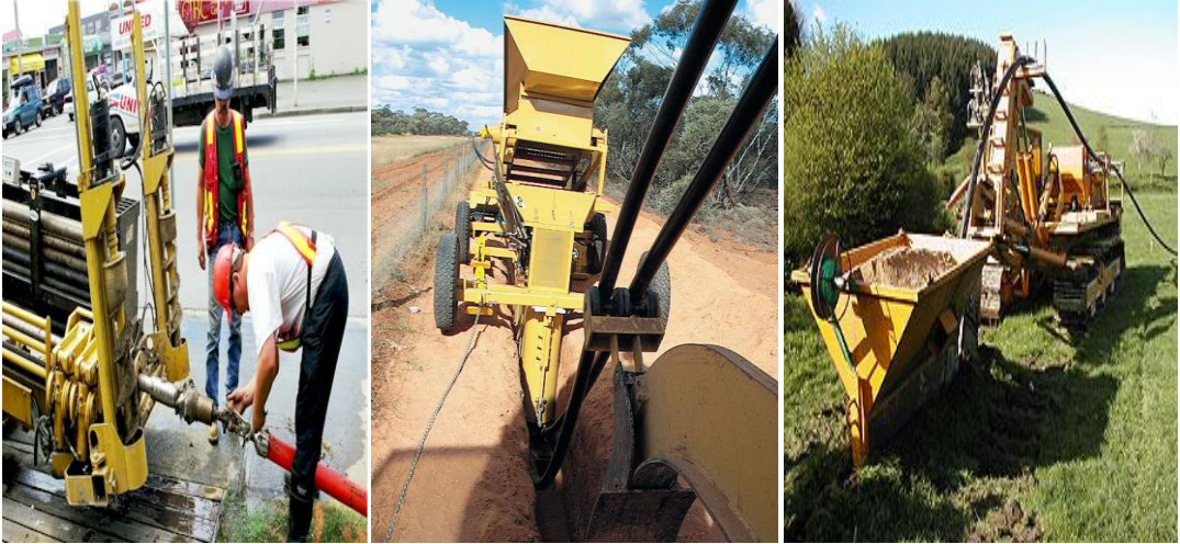
Resim 2.13: Kablonun çekme makinesine bağlanması ve makine ile döşenmesi
