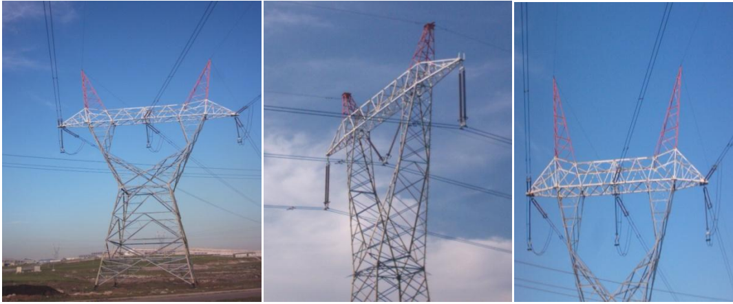
Resim 1.2: Çatal tipi demir direkler
