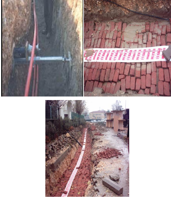
Resim 2.16: Kabloların kanala dōşenmesi ve tuđlaların yerleřtirilmesi
