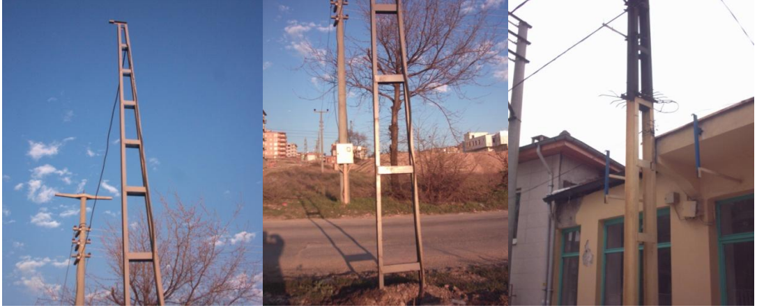
Resim 1.5: A tipi demir direkler
