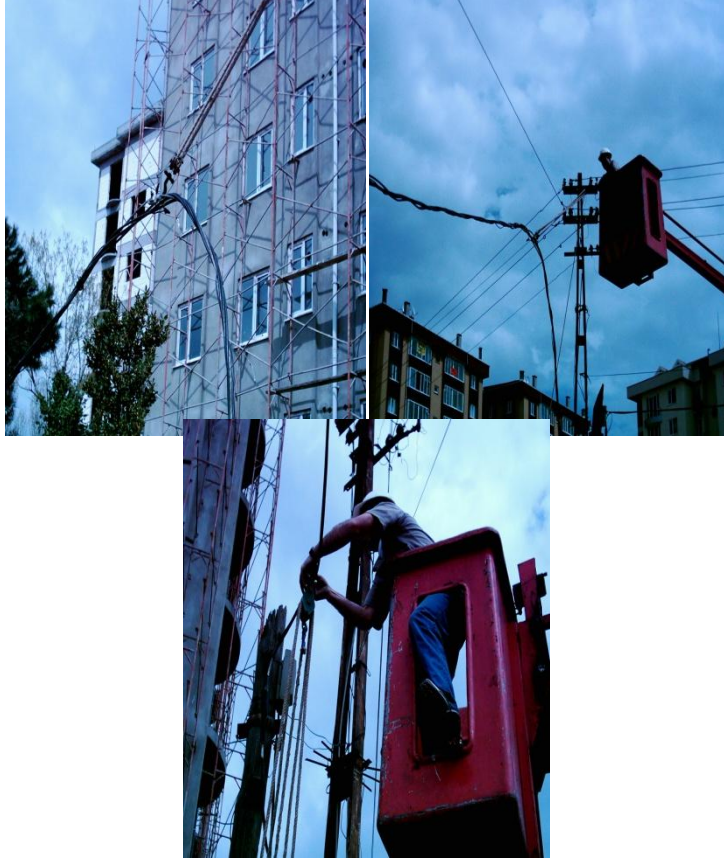
Resim 1.33: İletkenin direğe çekilmesi
