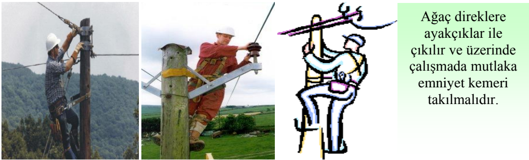
Resim 1.14: Ağaç direk üzerinde çalışma (emniyet kemerli)
