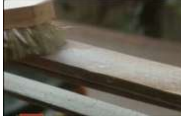
Resim 2.9: Metal yüzeyin fırça ile temizlenmesi
