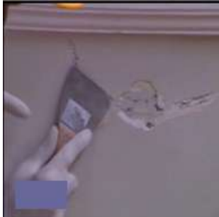
Resim 2.5: Eski boya ve çatlakların kazınması
