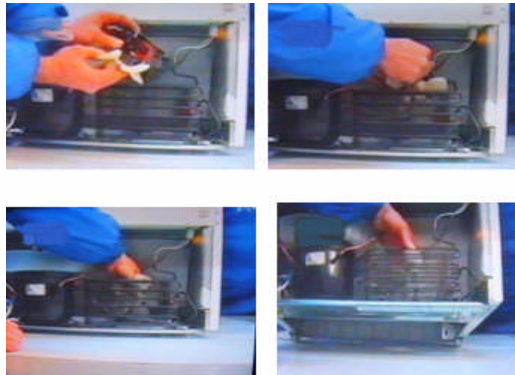
Resim 7.4: Yeni Kondenser fanının monte edilmesi
