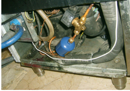
Resim 6.6: Su pompasının monte edilmiş hali
