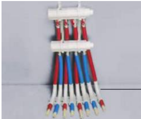
Resim 4.7: Boruların köşe düzelticiyle koruma altına alınması
