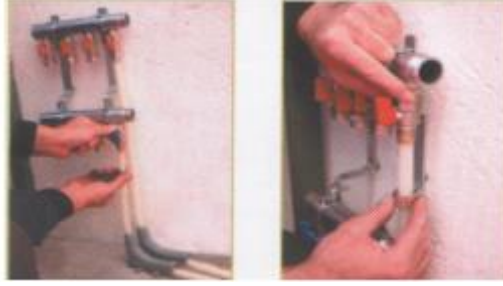
Resim 4.4: Kolektöre vanaların takılması
