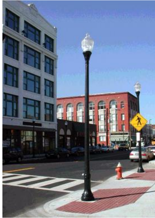
Resim 2.3: Yol kenarı aydınlatması
