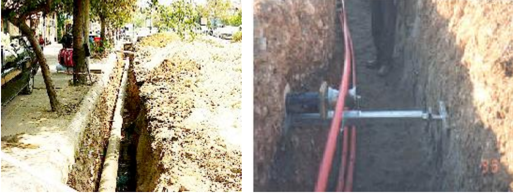
Resim 1.10: Enerji hatları için açılmış kanallar
