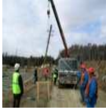
Resim 1.11: Vinç yardımıyla direk dikimi
