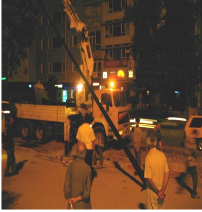
Resim 1.11: Vinç yardımıyla direk dikimi
