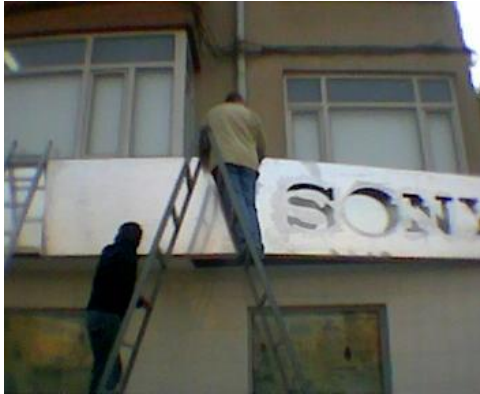
Resim 4.1: Reklam panosunun montajı
