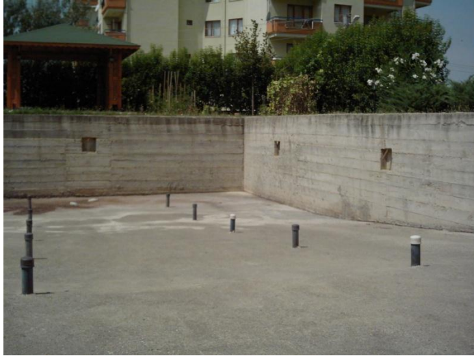
Resim 5.8: Havuz betonarmesi içinde bırakılmış aydınlatma elemanı boşlukları
