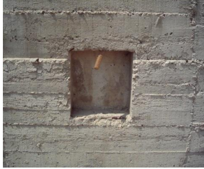
Resim 5.7: Havuz betonarmesinde aydınlatma elemanı için bırakılan eleman boşluğu
