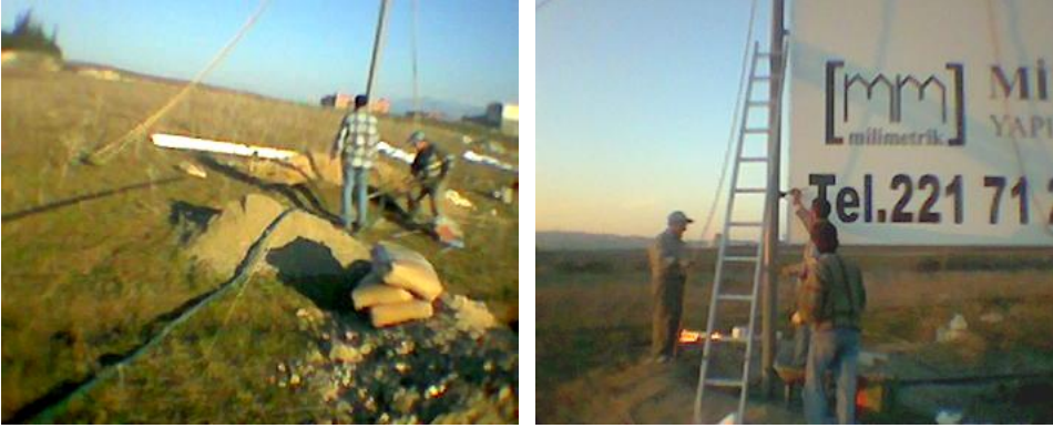
Resim 4.6: Reklam panosu kablo çekimi işlemi
