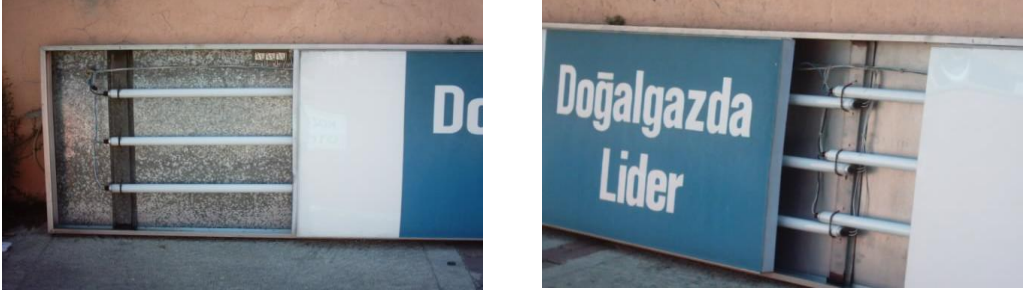
Resim 4.2: Floresan tip sistem reklam aydınlatmasında bağlantıların yapılması
