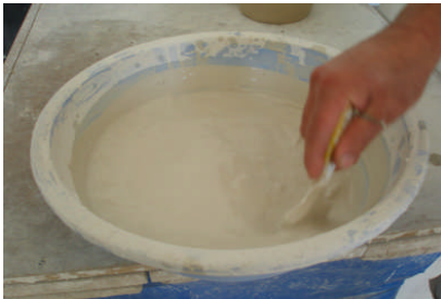
Resim 2.1: Astarın sulandırılması
