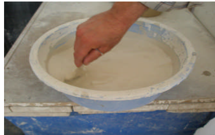
Resim 2.2: Astarın karıştırılarak hazırlanması
