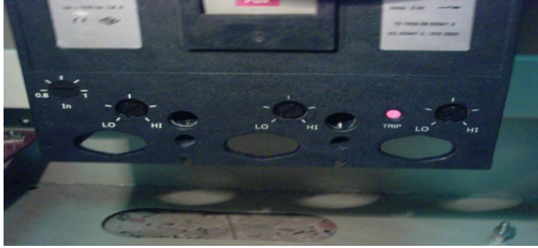
Resim 1.23: Kompakt şalter ayar bölümü ve trip butonu
