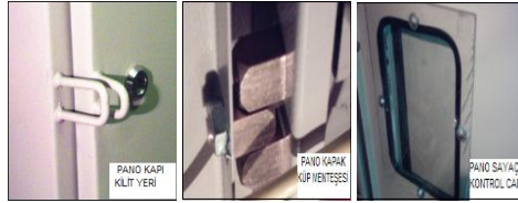
Resim 1.1: Ölçüm pano kapak özellikleri
