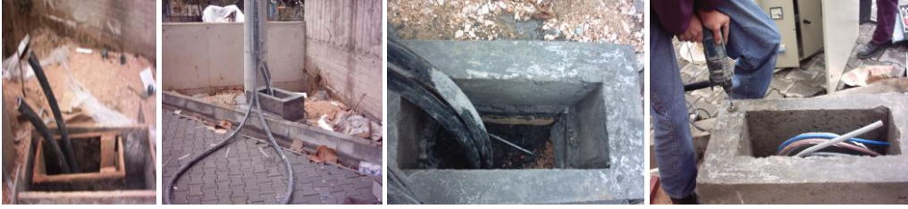
Resim 1.31: Ölçüm panosunun yerine montajı
