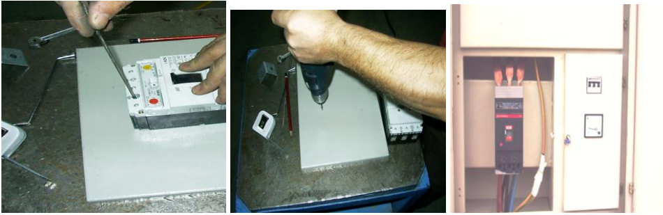
Resim 1.19: Kompakt şalterin montajı
