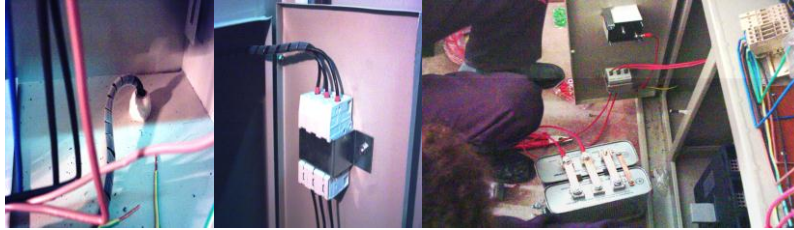
Resim 1.29: Sabit kompanzasyon kondansatör bağlantıları
