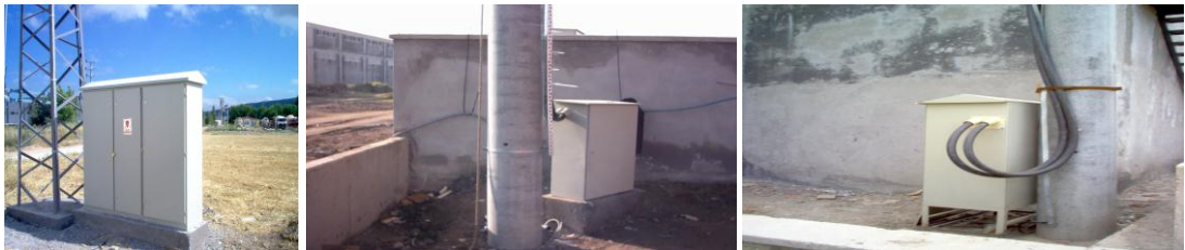
Resim 1.33: Ölçüm panosu AG ve kompanzasyon panosu birlikte ve direk dibine montajı
