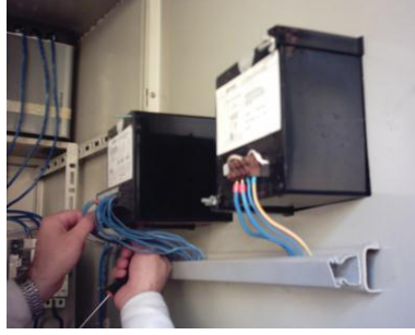
Resim 3.11: Regler montajı
