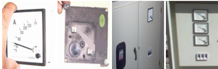
Resim 1.24: Ampermetre montajı
