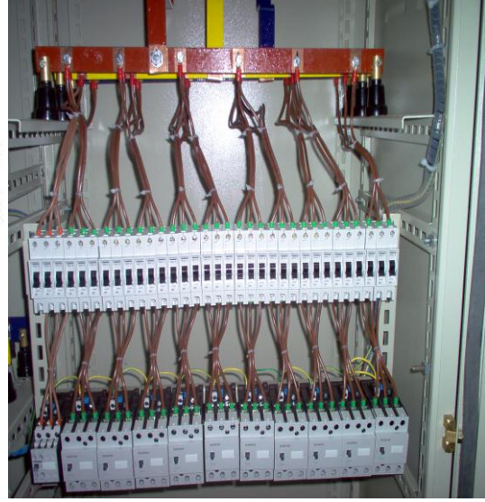
Resim 3.8: Anahtarlı otomatik sigorta
