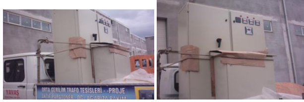
Resim 1.30: Ölçüm panosunun montaj yerine taşınması
