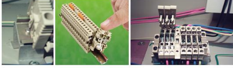
Resim 1.14: Klemenslerin montaj rayına tutturulması
