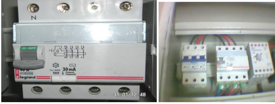
Resim 1.9: Kaçak akım koruma rölesi
