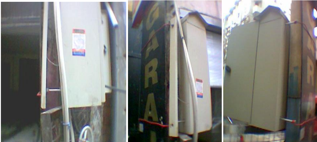
Resim 1.29: Şantiye tablosunun direğe tutturulması
