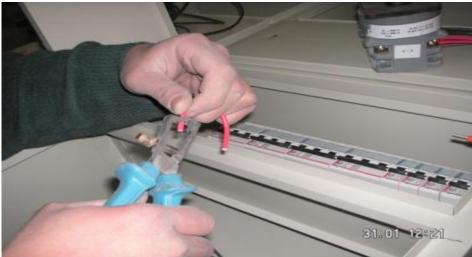
Resim 1.23: Kablo uçlarının açılması
