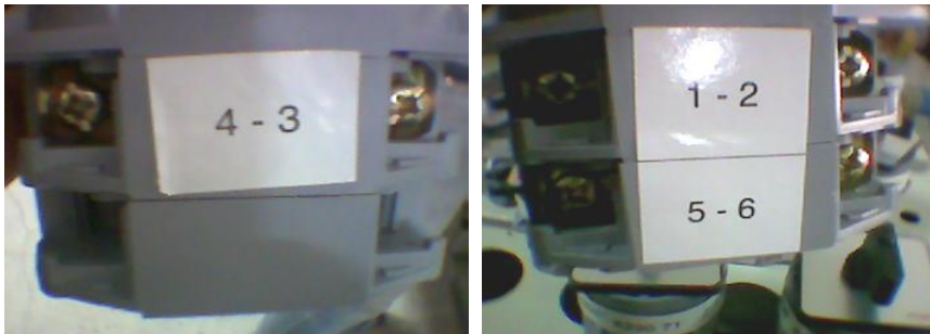
Resim 2.10: Pako şalterler ve iç bağlantı uçlarının numarası
