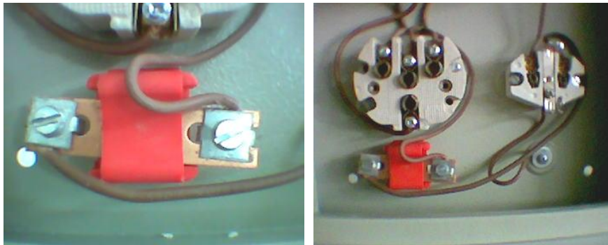
Resim 1.17: Prizlerin nötr iletkenlerinin bir bara üzerinde birleştirilmesi
