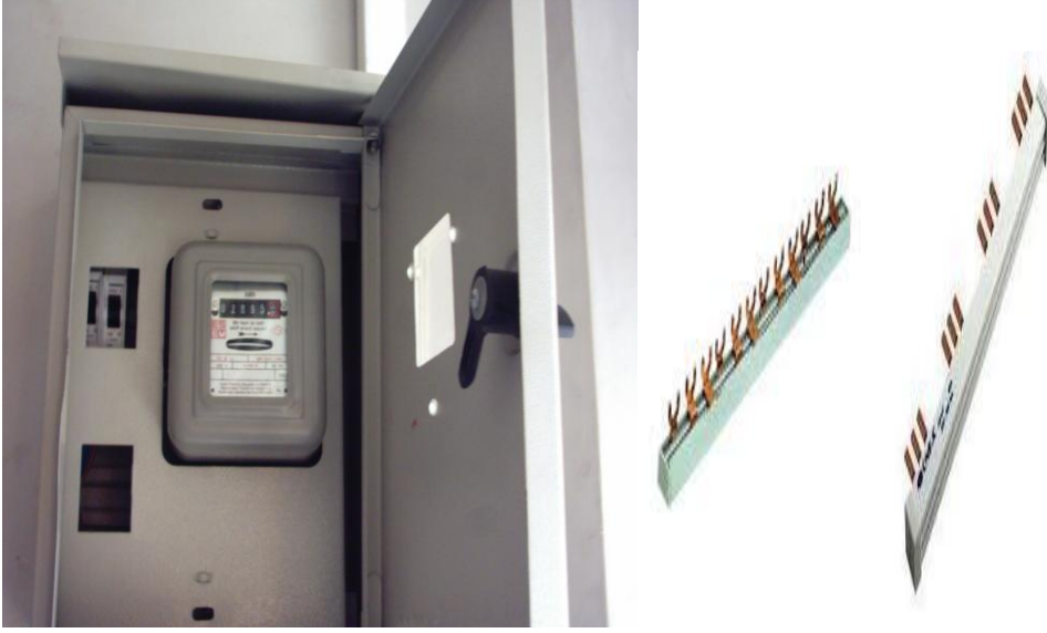
Resim 3.1: Sıva üstü kat dağıtım tablosu ve W otomat barası
