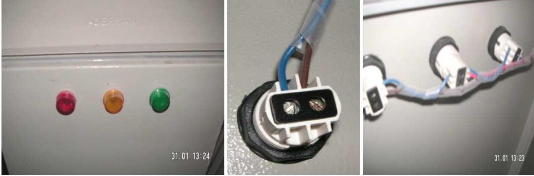
Resim 2.16: Tabloda bulunan 3 faz için sinyal lambaları
