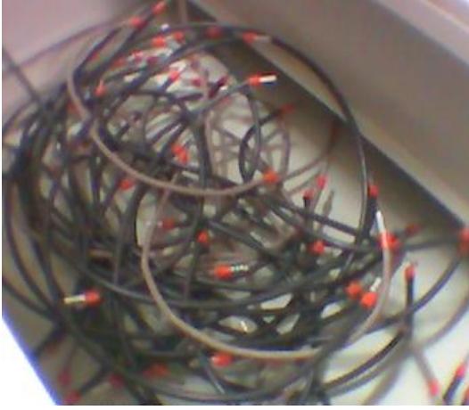
Resim 1.24: Kablo yüksüğü takılması
