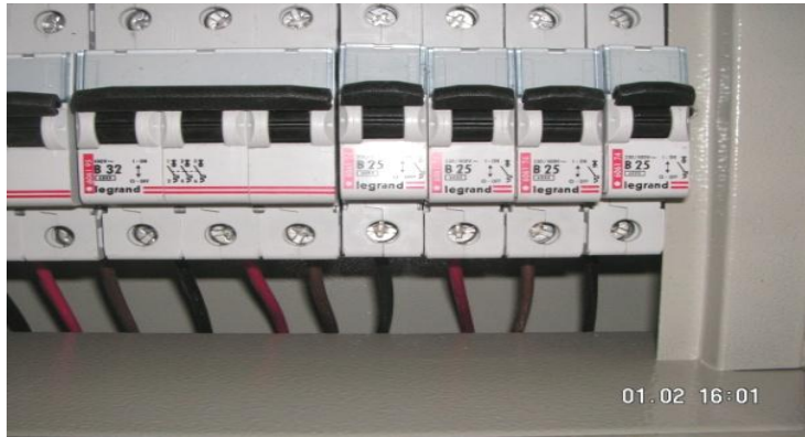
Resim 1.15: Bir fazlı ve üç fazlı otomatların tablodaki yerleri
