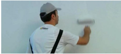
Resim 2.8: Yüzeyin astarlanması
