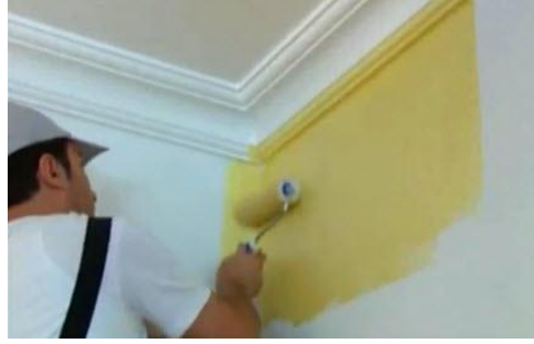
Resim 2.10: Kestirme işleminin rulo ile yapılması
