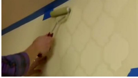
Resim 2.15: Rulo ile desenin duvara aktarılması
