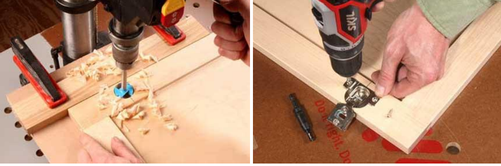
Resim 2. 16: Küçük parçalar için siper yapma
