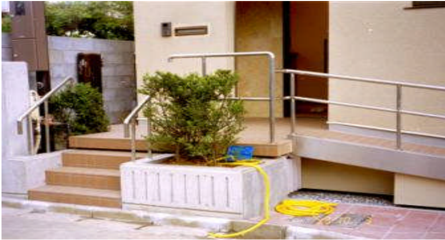
Resim 2. 9: Sismik yalıtımlı bir binanın giriş kısmı
