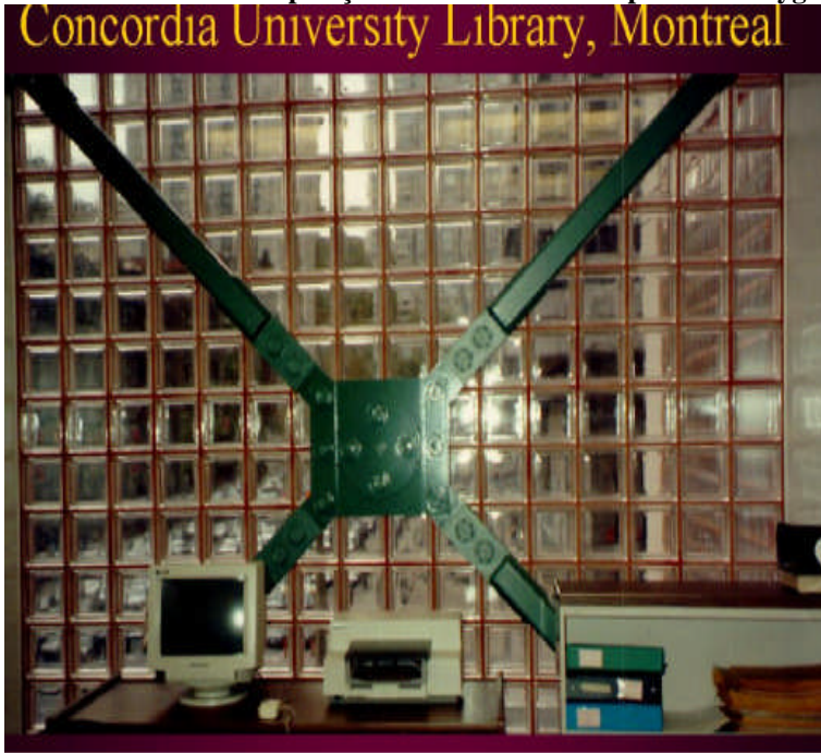
Resim 2. 22: Damper sistem uygulaması yapılmış bir kütüphane
