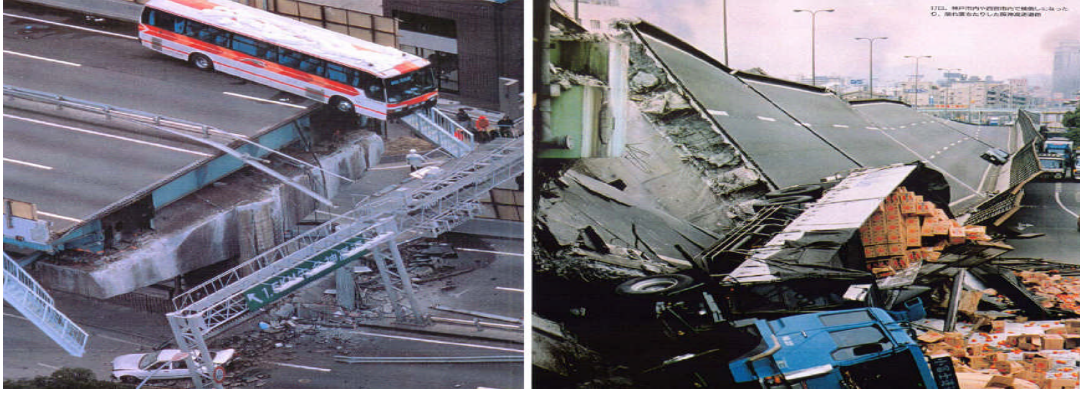
Resim 2.15: 1995 Kobe Depreminde yıkılan bir köprü ve viyadük
