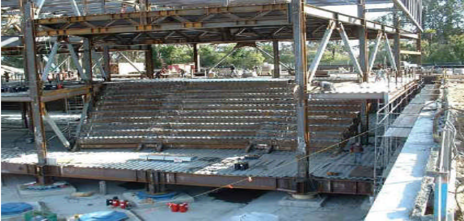
Resim 2. 12: Kauçuk ve sürtünme esaslı izolatörlerin karma olarak kullanıldığı bir çelik yapı sistemi
