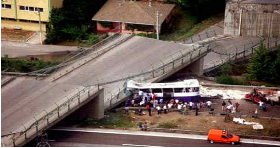
Resim 1.1 : 17 Ağustos 1999 Marmara Depreminde hasar görmüş bir köprü
