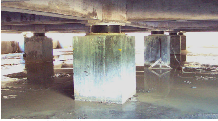
Resim 2. 8: Kauçuk izolatör uygulamasından bir görünüm
