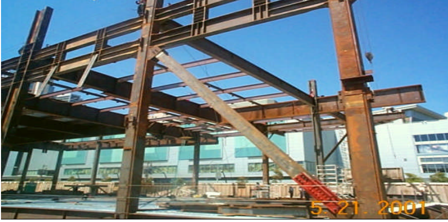
Resim 2.19:Sönümlendirici cihazların uygulandığı inşaattan bir fotoğraf
