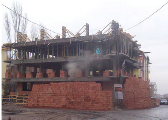
Resim 2. 3: Proje şekline göre duvarlar örülmeli
