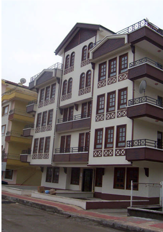
Resim 2. 5: Yapının bütün imalat işleri bitince “Yapı kullanım izni” alınmalı
