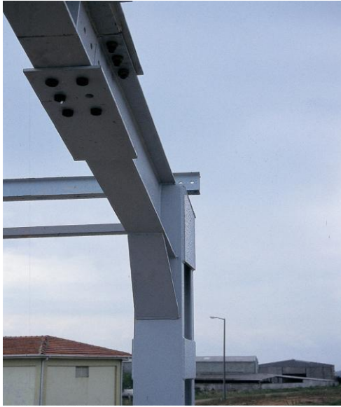
Resim 2.6: Çelik yapı birleşim noktaları
