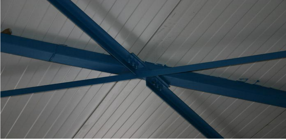
Resim 2.8: Çelik yapı birleşim noktaları
