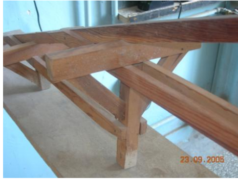
Resim 1.21: Dikmelerin kuşak vasıtası ile desteklenmesi
