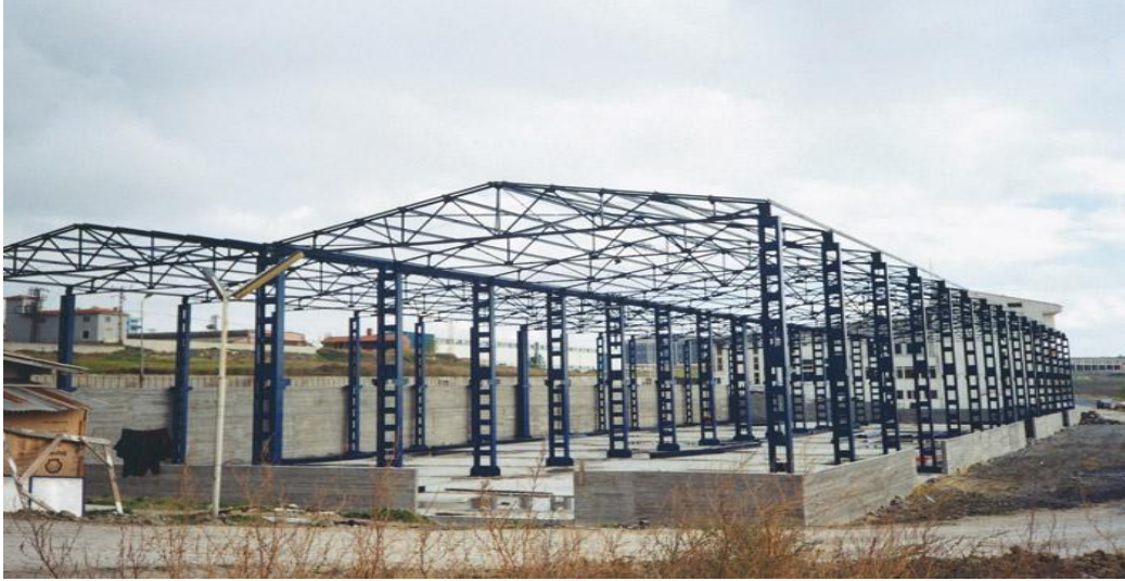
Resim 2.9: Çelik yapının taşıyıcı sistemi
