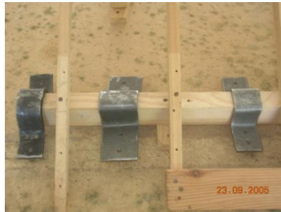
Resim 1.19: Aşıkların kenetlerle desteklenmesi
