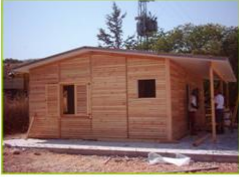
Resim 2.14: Ahşap iskelet yapının bölme duvarları ve tamamının montajı
