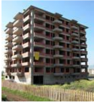
Resim 2.1: Kolonları kesintisiz yapılmış kâgir bina
