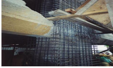
Resim 1.9: Betonarme kolonun desteklenmesi
