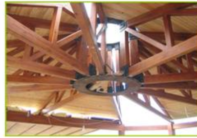
Resim 2.13: Ahşap iskelet yapının taşıyıcı sisteminin montajı
