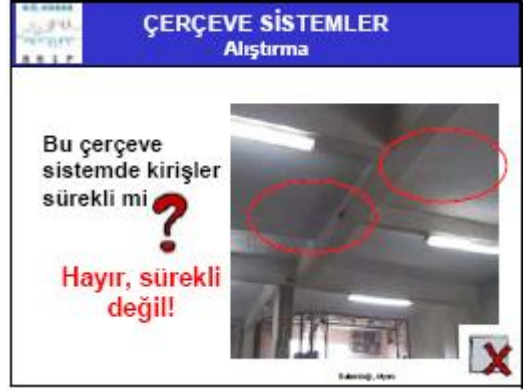
Resim 2.5: Hatalı çerçeve sistemli kiriş
