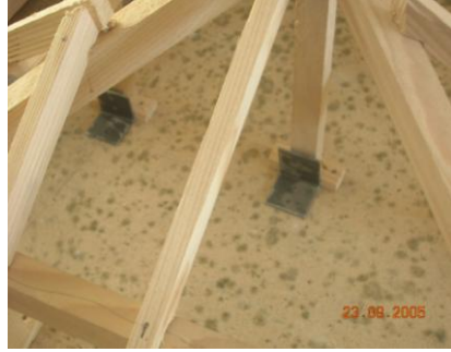
Resim 1.20: Dikmelerin küşebentlerle desteklenmesi
