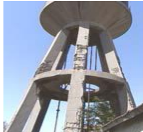
Resim 1.5: Betonun patlaması
