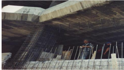
Resim 1.11: Betonarme kirişin desteklenmesi
