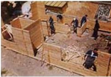
Resim 2.13: Ahşap iskelet yapının taşıyıcı sisteminin montajı
