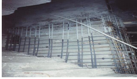
Resim 1.10: Betonarme kolonun desteklenmesi
