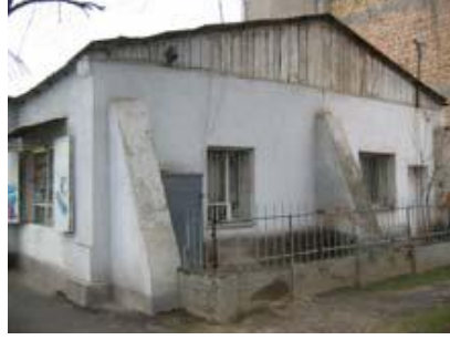
Resim 1.19: Yığma bina duvar desteklenmesi
