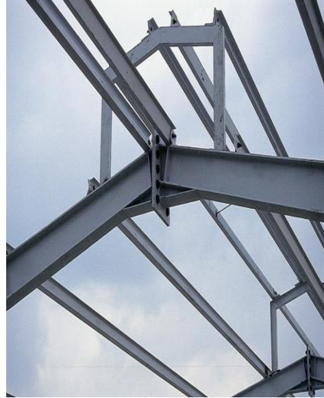
Resim 2.7: Çelik yapı birleşim noktaları
