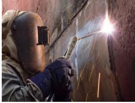
Resim 1.2: Elektrik ark ile dik kaynak
