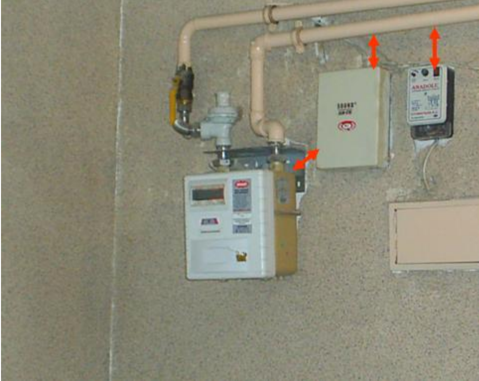
Resim 2.8: Boruların elektrik tesisatlarına mesafeleri
