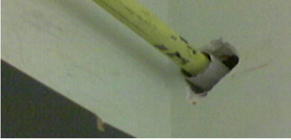
Resim 2.1. Gaz borusu ile kılıf arasının mastik dolgu ile doldurulması
