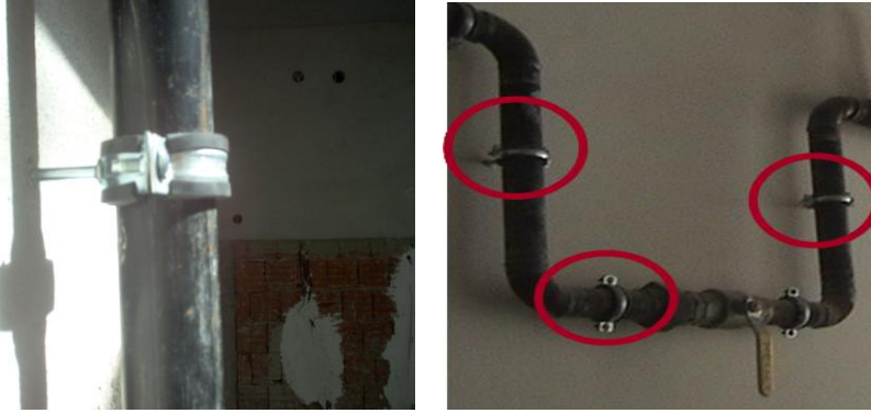
Resim 2.6: Boruların yapı elemanlarına sabitlenmesi
