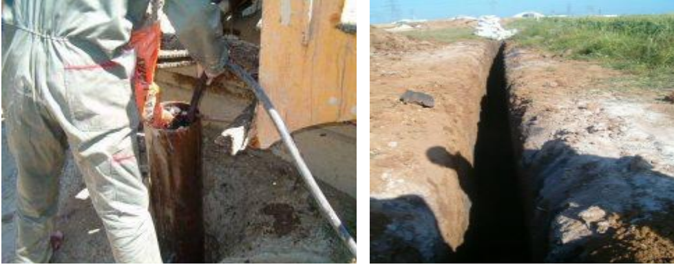
Resim 1.14: Dikey ve yatay anot yatağına kok tozu doldurulması
