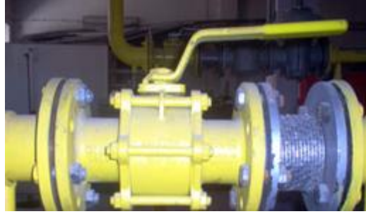
Resim 3.2: Ana gaz kesme vanası(Flanş bağlantılı)
