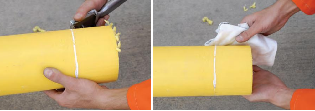
Şekil 2.1: Polietilen boru kazıma
