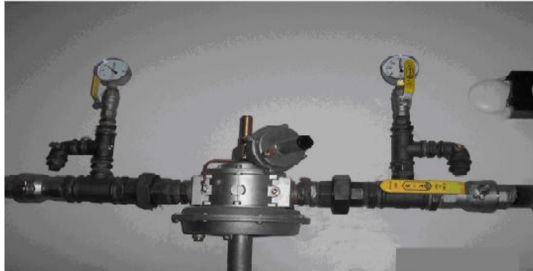
Resim 1.12: Regülatörün gaz tesisatındaki yeri
