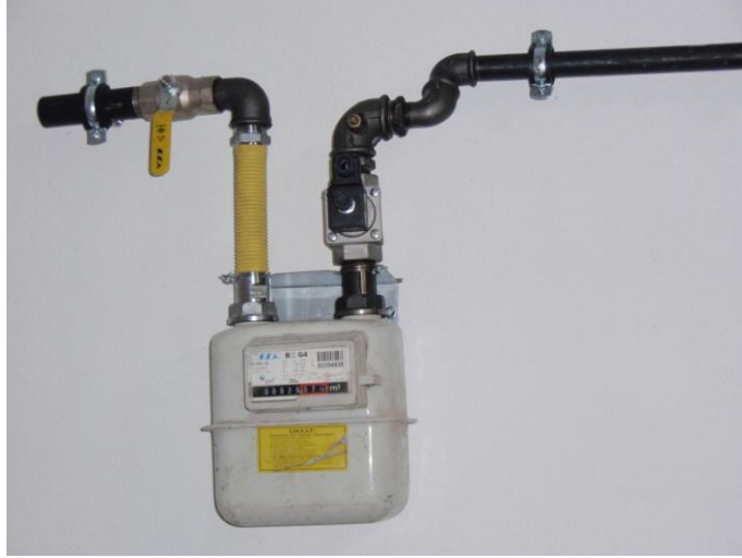
Resim 3.8: Sayaç ve küresel vana bağlantı uygulaması
