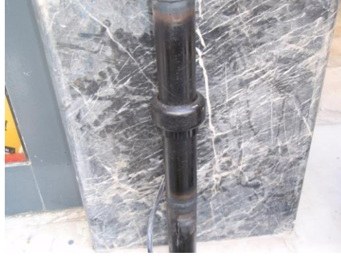
Resim 1.12: İzalasyon flanşı bina girişi uygulaması
