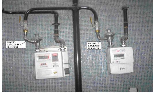
Resim 3.5: Ankara'da uygulanan sayaca esnek bağlantı ve regülâtörün bağlanması
