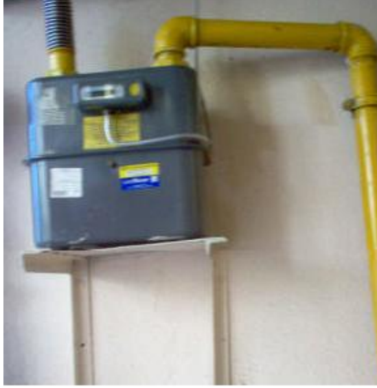
Resim 3.9: Doğalgaz sayacının destek üzerine bağlantı uygulaması
