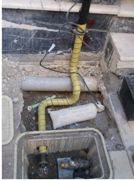
Resim 1.10: Toprak üstüne çıkan PE borunun sıcak sargı yapılan binaya gazın alınması işlemi ile izole edilmesi
