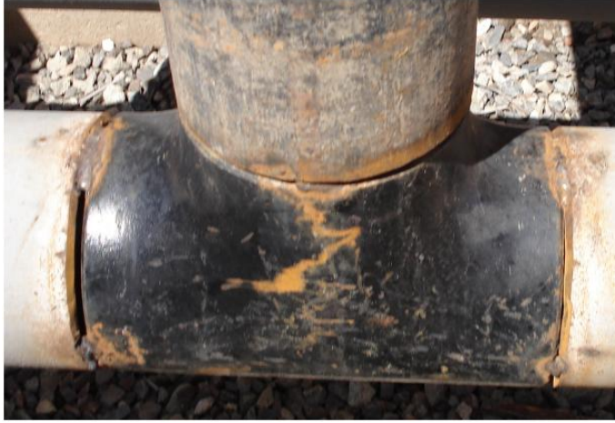
Resim 2.1: Ağız alınmış doğal gaz borusu
