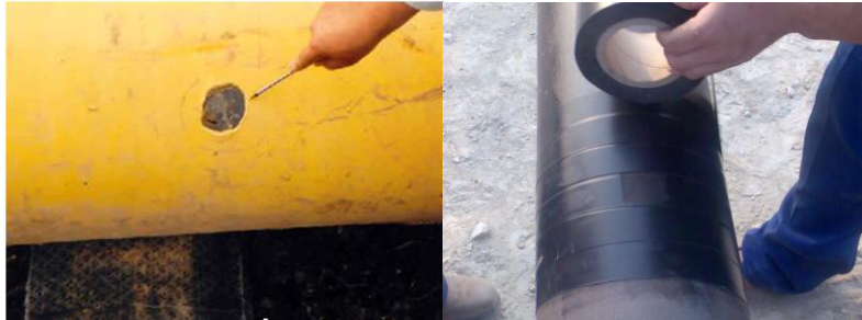
Resim 2.2: Gaz borusunun sıcak sargı yapılması
