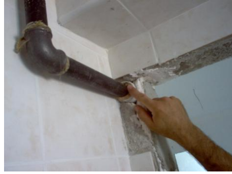
Resim 1.8. Gaz borusu ile kılıf arasının mastik dolgu ile doldurulması
