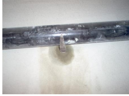
Resim 3.5: Kolon borularının konsol ile sabitlenmesi
