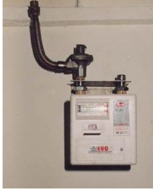
Resim 3.8: Ankara'da uygulanan sayaca esnek bağlantı elemanın ve governor regülatörün bağlanması
