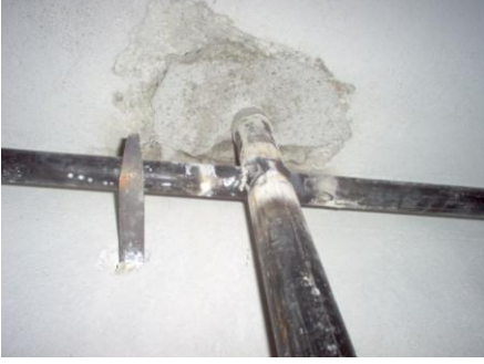
Resim 3.5: Kolon borularının konsol ile sabitlenmesi
