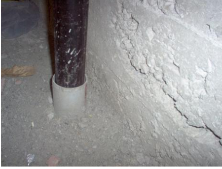
Resim 1.7. Döşemeden Kılıf Geçirme
