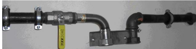
Resim 3.7: Sayaç Bağlantı yerinin hazırlanması
