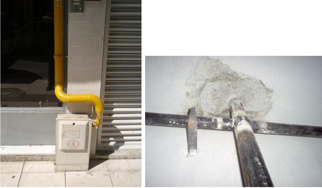
Resim 3.1: Kolon tesisatı borularının kaynaklı birleşimi
