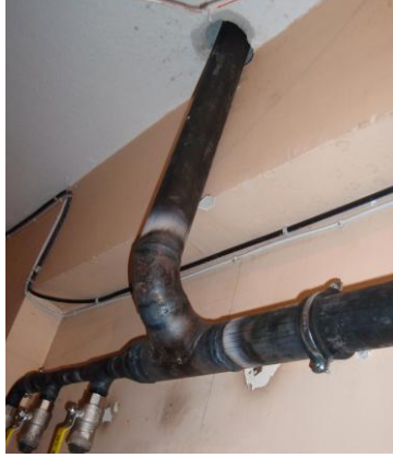
Resim 3.2 : Kolon tesisatında dönüşlerin patent dirsekle yapılması
