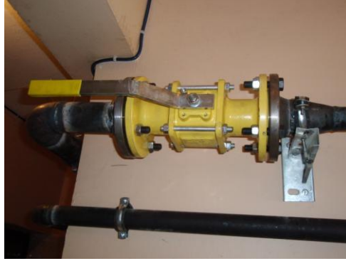
Resim1.5: Flanşlı birleştirme
