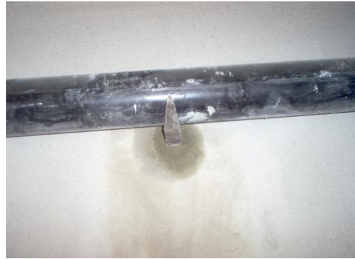
Resim 1.10:Gaz borularının konsollar üzerine desteklenmesi
