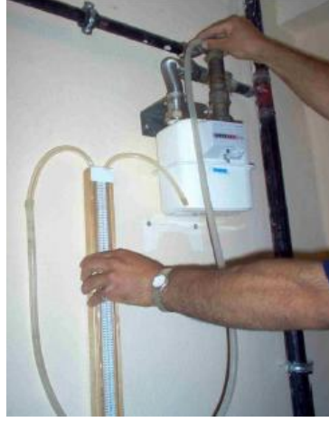
Resim 4.4:U- manometre ile sızdırmazlık testi
