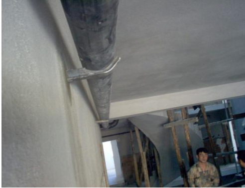
Resim 1.10:Gaz borularının konsollar üzerine desteklenmesi
