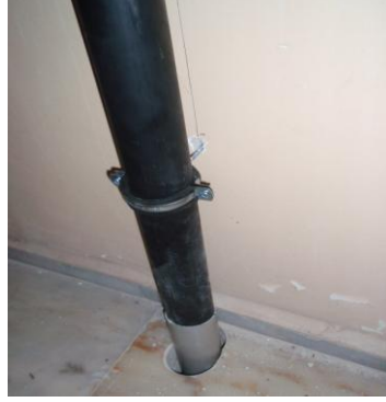
Resim 3.3:Koruyucu kılıfın döşeme üzerine çıkarılması
