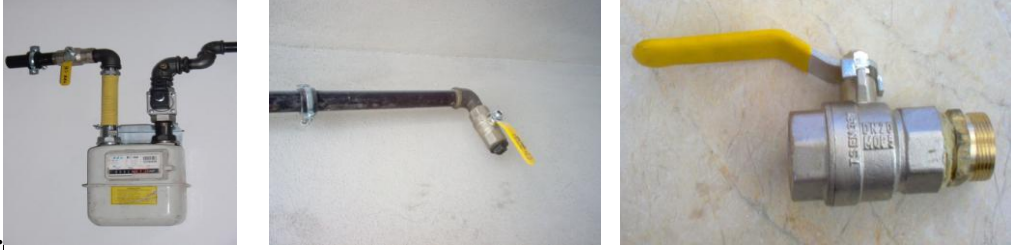
Resim 3.10 : Küresel gaz kesme sayaç vanası
