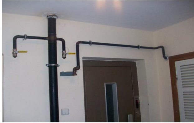
Resim 3.4: Kolon borularının kelepçe ile sabitlenmesi
