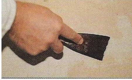
Resim 1.5: Çatlakların alçıyla doldurulması
