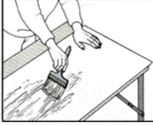
Resim 2.10: Duvar kâğıdının tutkallanması
