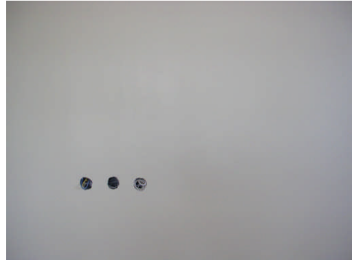
Resim 1.2: Saten alçı perdahlı duvar yüzeyi
