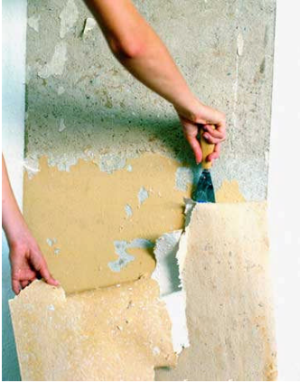
Resim 1.4: Eski duvar kâğıdının sökülmesi
