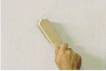
Resim 1.7: Yüzeyin fırçalanması
