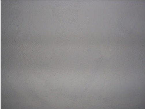
Resim 1.1: İnce sıvalı duvar yüzeyi
