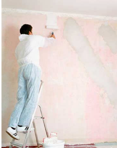
Resim 1.9: Yüzeye sulandırılmış beyaz tutkal sürülmesi
