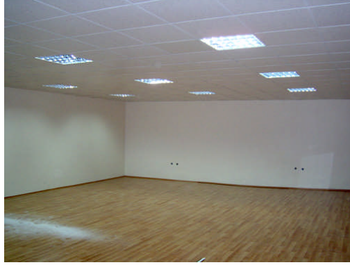
Resim 1.3: Alçı panel levha duvar yüzeyi
