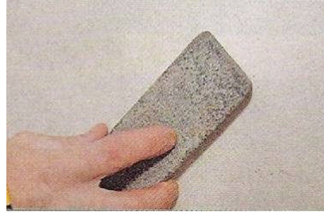
Resim 1.8: Yüzeyin zımparalanması
