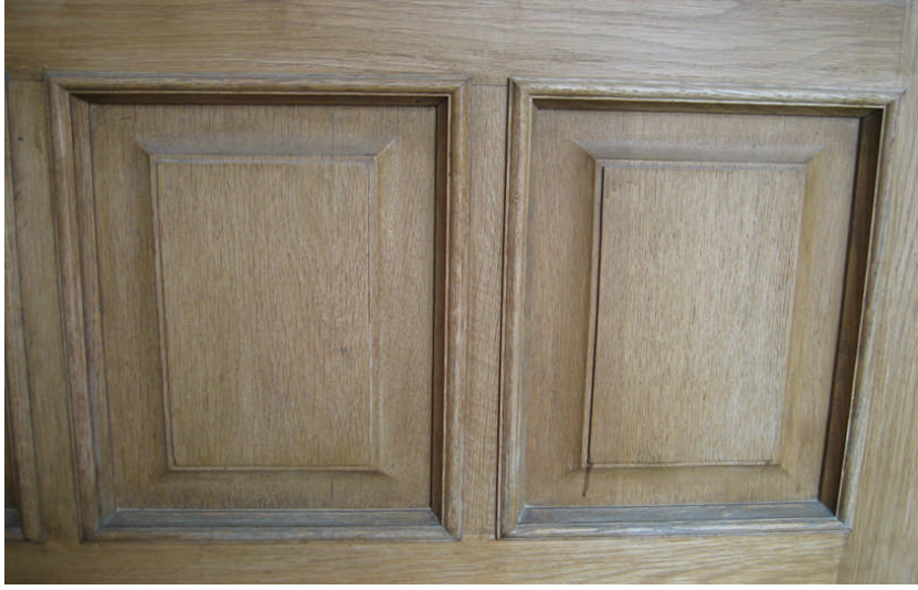
Resim 1.4: Çerçeve tabla görünümlü duvar kaplaması
