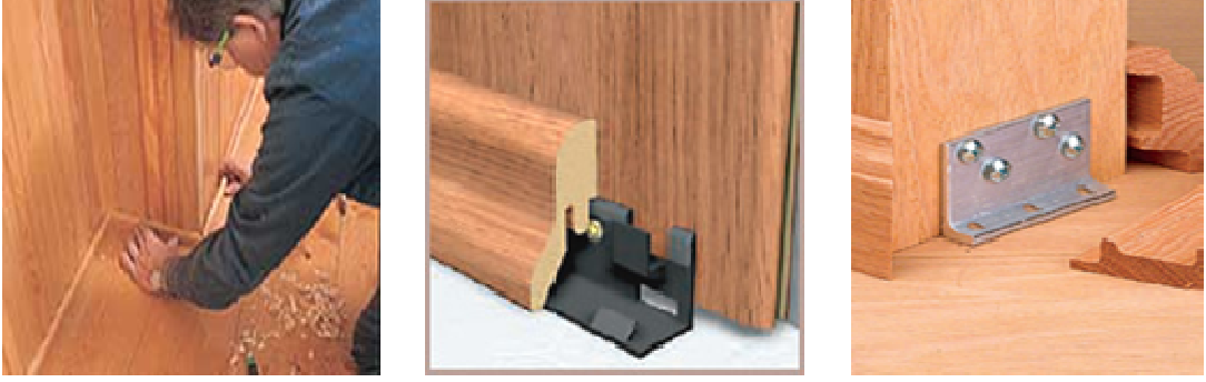
Resim 2.7: Duvar kaplaması zemin açıklıklarının süpürgelik çıtalarıyla kapatılması
