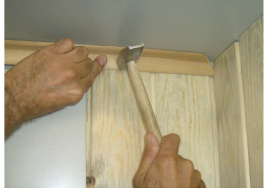
Resim 2.5: Tavan açıklıklarının uygun çıtalarla kapatılması
