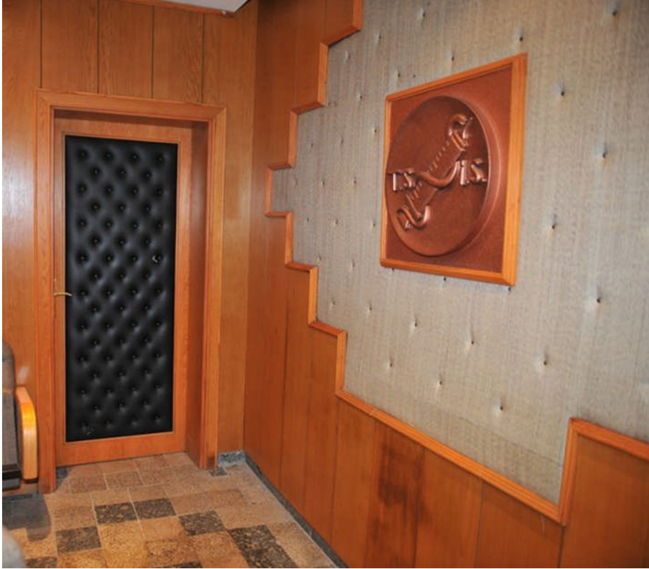
Resim 1.1: Karışık bir duvar kaplama uygulaması
