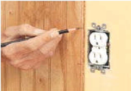
Resim 2.4: Elektrik priz yerlerinin işaretlenmesi
