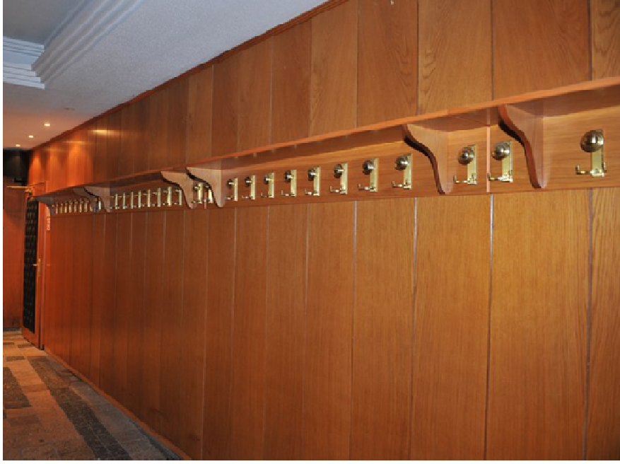
Resim 1.3: Geniş tabla görünümlü duvar kaplama uygulaması
