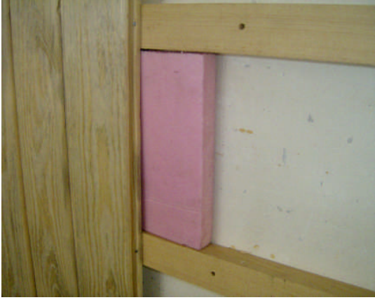
Resim 2.3: Alt karkas sistemini teraziye almak ve lambri döşeme
