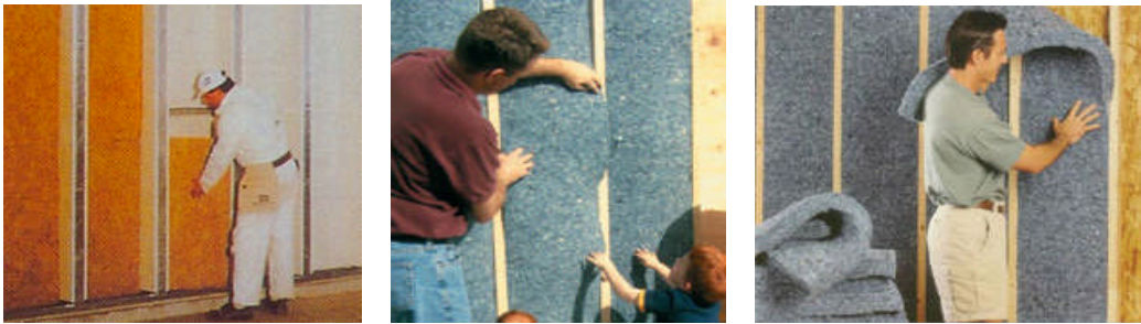
Resim 2.2: Yalıtım malzemelerinin karkaslar arasına döşenmesi
