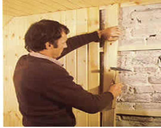
Resim 2.3: Alt karkas sistemini teraziye almak ve lambri döşeme
