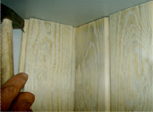
Resim 2.5: Tavan açıklıklarının uygun çıtalarla kapatılması
