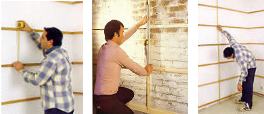
Resim 2.1: Duvarda alt konstrüksiyon çitalarının bağlanması ve teraziye alınması
