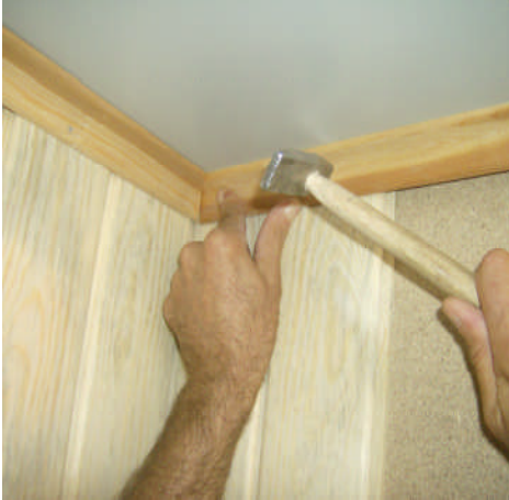
Resim 2.6: Köşe ve tavan açıklıklarının uygun çıtalarla kapatılması
