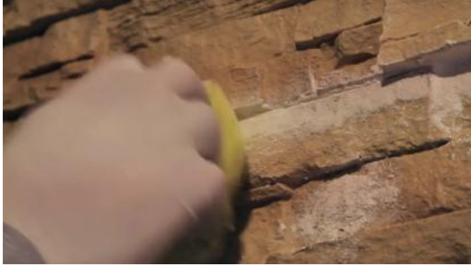
Resim 2.44: Derz dolgu malzemesi üzerinde desen devamlılıđı için gerekli düzenlemelerin yapılması
