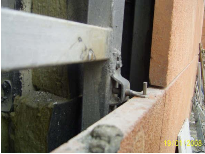
Resim 2.27: Taş plakaların monte edilmesi
