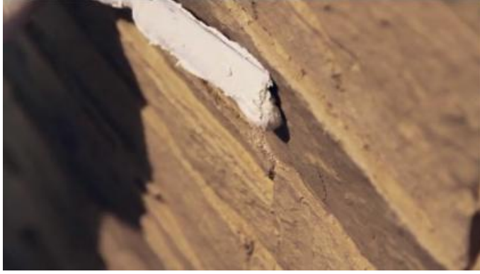
Resim 2.40: Derz dolgu malzemesinin ince spatula ile vidalar üzerine uygulanması
