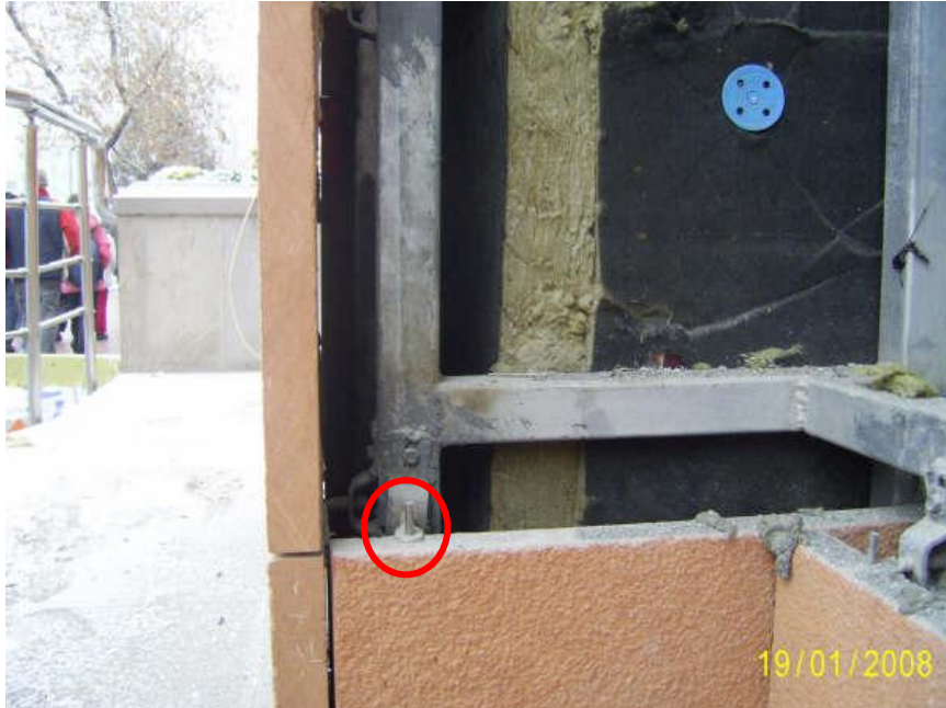
Resim 2.13: Tesisat ve yalıtım işleri
