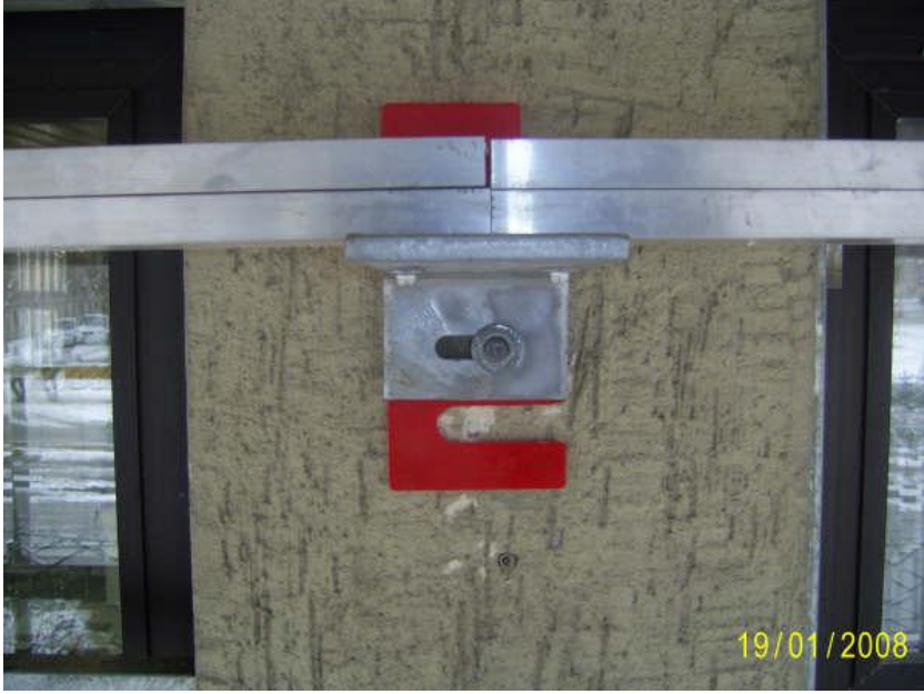
Resim 2.21: Profillerin duvara montajı
