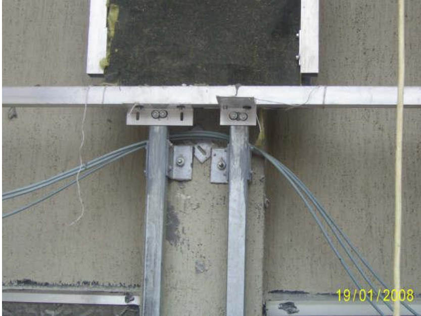
Resim 2.18: Profillerin yerleştirilmesi
