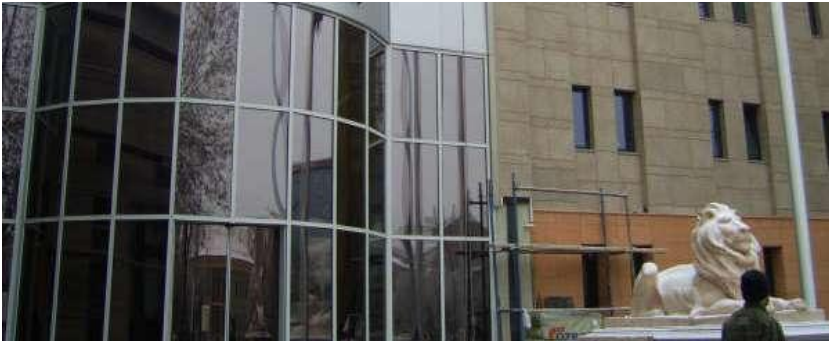
Resim 2.1: Dış duvarda cam ve taş kaplama
