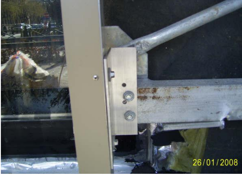
Resim 2.22: Profillerin montajı
