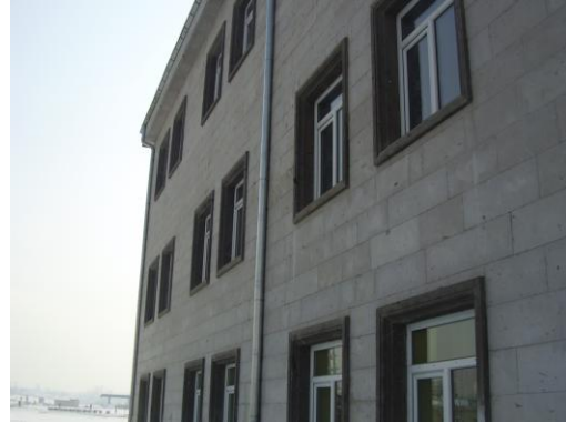
Resim 2.31: Taş kaplanmış yüzey
