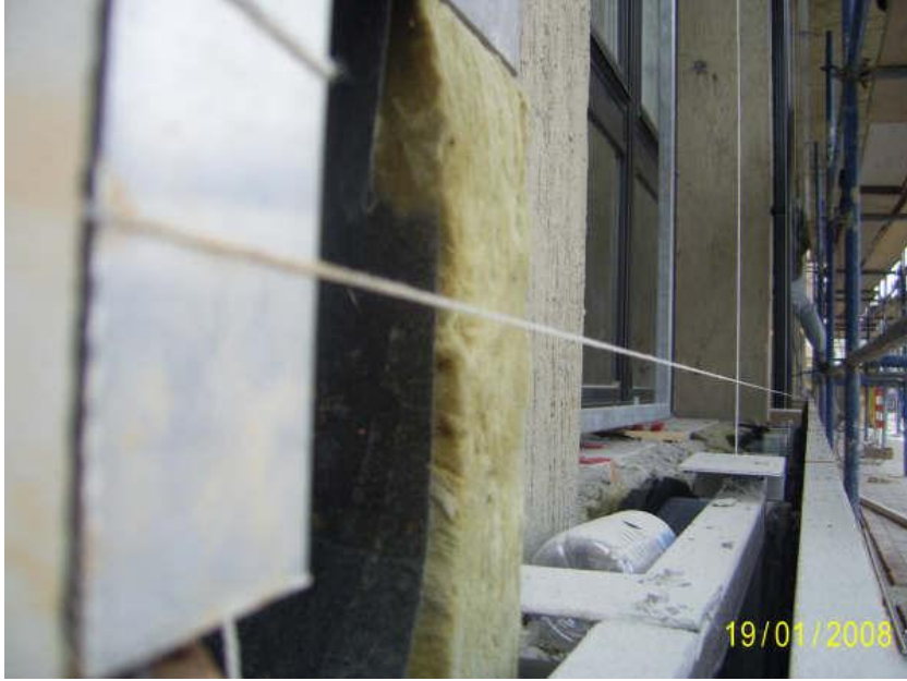
Resim 2.14: Tesisat ve yalıtım işleri
