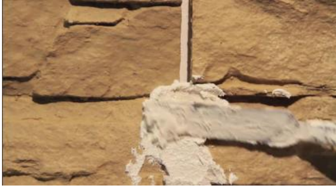
Resim 2.41: Derz dolgu malzemesinin ince spatula ile dikey derze uygulanması
