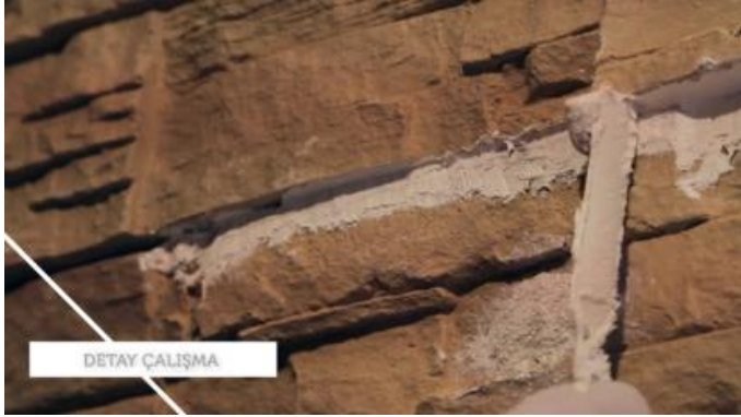
Resim 2.42: Derz dolgu malzemesinin ince spatula ile yatay derze uygulanması
