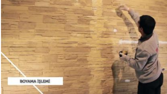
Resim 2.45: Derz dolgu malzemesinin panellerin orijinal boyası ile boyama işlemi
