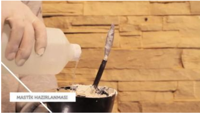
Resim 2.39: Derz dolgu malzemesinin hazırlanması
