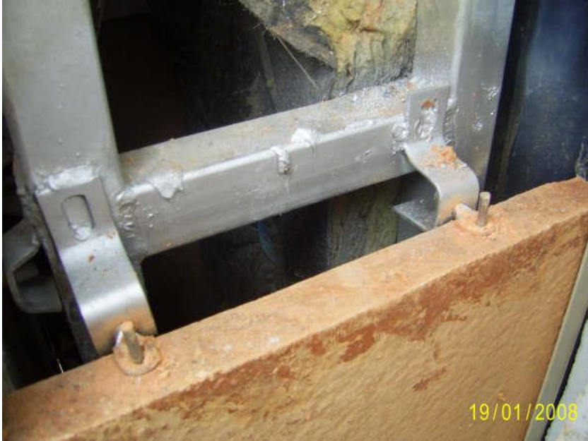
Resim 2.26: Taş plakaların monte edilmesi
