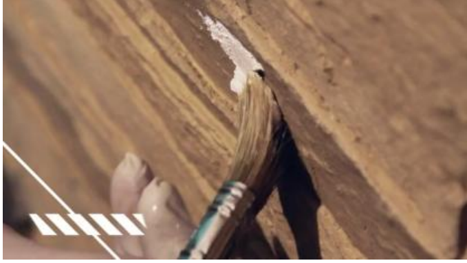
Resim 2.43: Derz dolgu malzemesi üzerinde desen devamlılıđı için gerekli düzenlemelerin yapılması
