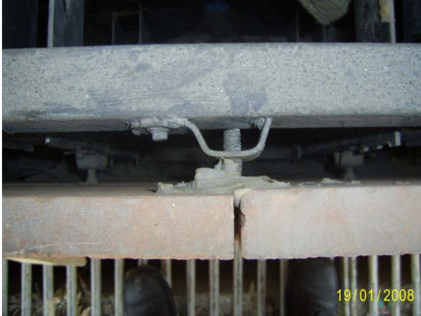
Resim 2.28: Taş plakaların monte edilmesi
