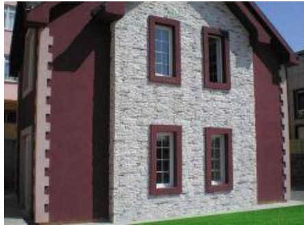
Resim 1.15: Yapay taş kaplama yapılmış bina
