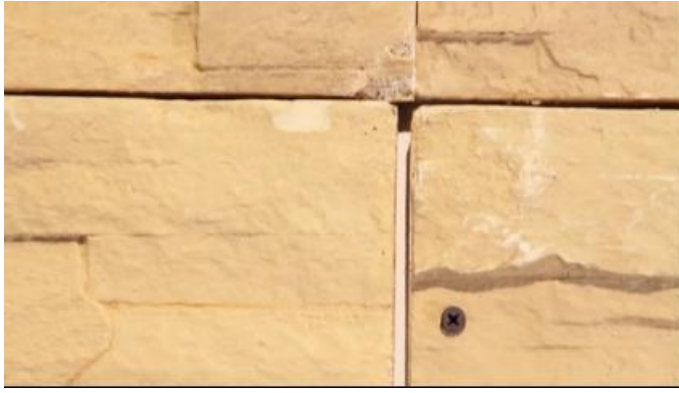
Resim 2.38: Derz aralıklarından ya da yüzeye temas eden kısımlardan vidalanarak panellerin monte edilmesi
