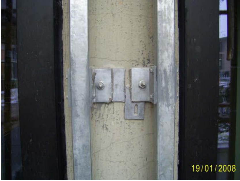
Resim 2.17: Profillerin montajı
