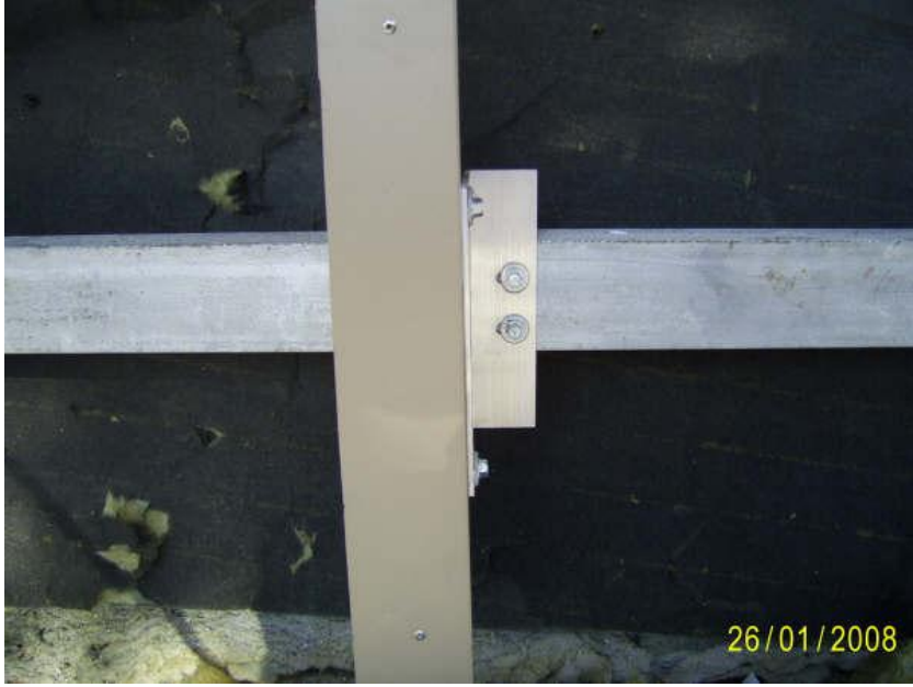
Resim 2.19: Profillerin montajı
