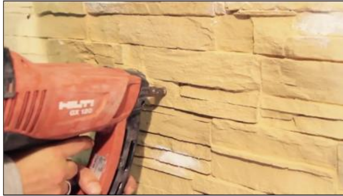
Resim 2.36: Derz aralıklarından ya da yüzeye temas eden kısımlardan vidalanarak panellerin monte edilmesi
