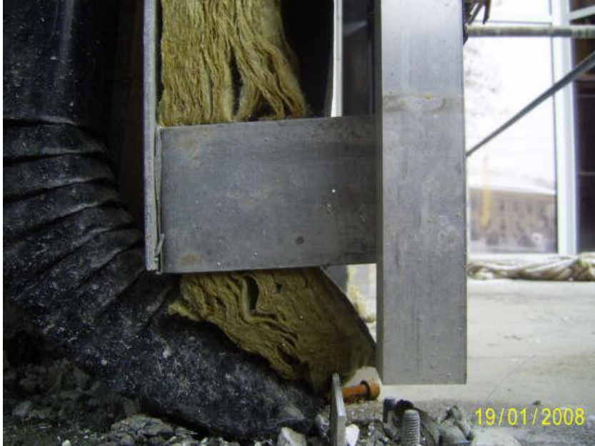
Resim 2.20: Profillerin montajı (zemin detayı)
