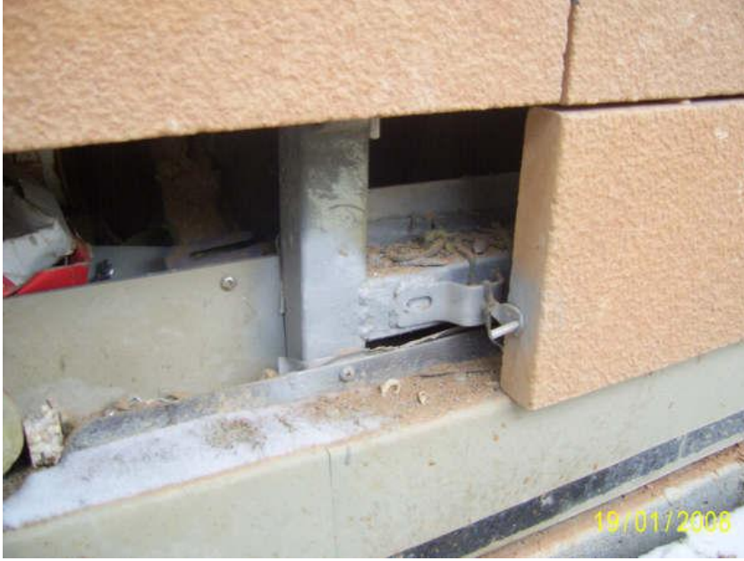
Resim 2.25: Taş plakaların monte edilmesi
