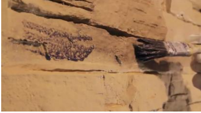
Resim 2.46: Derz dolgu malzemesine orijinal panel renginin kazandırılması
