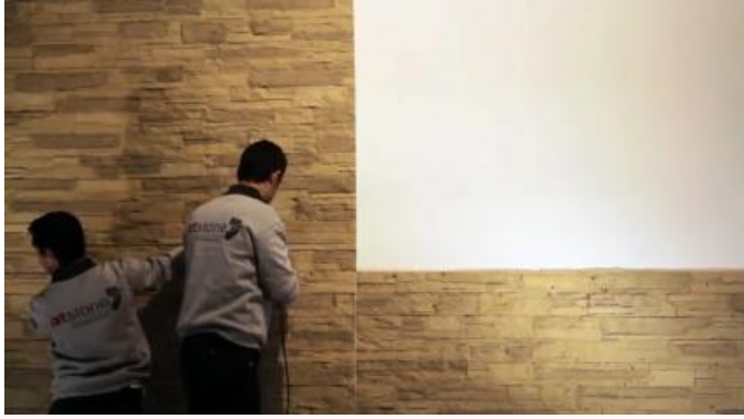
Resim 2.37: 3. Panelin montajı
