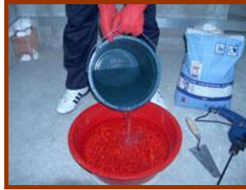
Resim 2.3: Yapıştırma harcı için su koyulması
