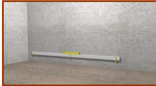
Resim 1.11: Mastarın metal mastar ayakları ile sabitlenmesi
