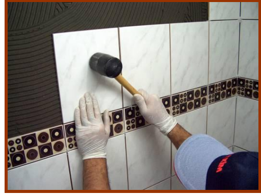
Resim 3.11: Seramik karonun el ile yerleştirilmesi ve tokmaklanması
