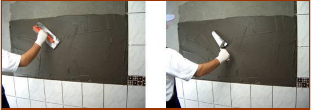
Resim 3.9: Yapıştırma harcının yüzeye sürülmesi
