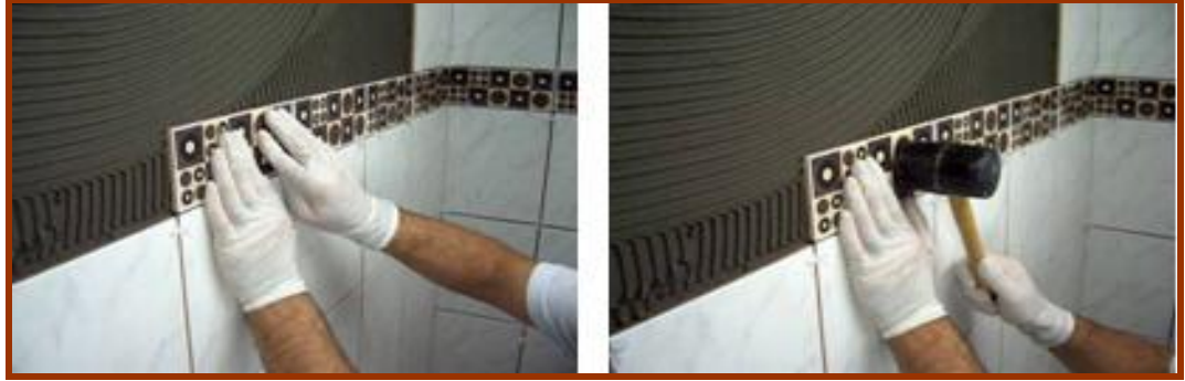
Resim 3.12: Bordürün el ile yerleştirilmesi ve tokmaklanması
