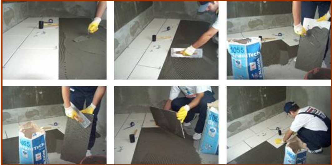
Resim 3.4: Kombine yöntemi uygulama aşamaları
