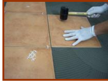
Resim 3.2: Seramiğin yerleştirilmesi ve tokmaklanması
