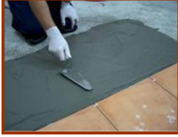
Resim 3.1: Yapıştırma harcının serilmesi ve taraklanması
