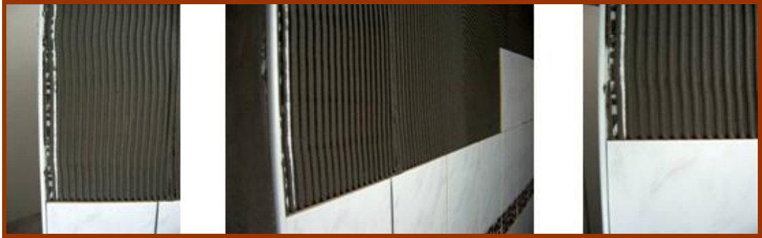
Resim 3.15: Köşe profillerinin yerleştirilmiş hâli
