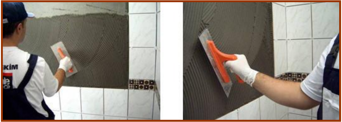
Resim 3.10: Yapıştırma harcının tesviyesi ve taraklanması
