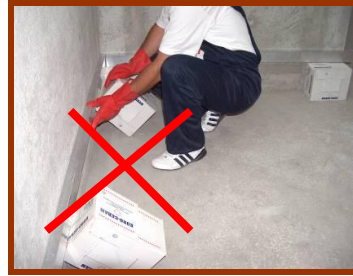
Resim 1.8: Masterların seramik kutularıyla desteklenmesi
