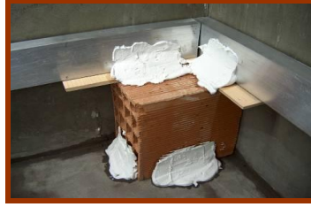
Resim 1.2: Alüminyum master ve tuğla takoz
