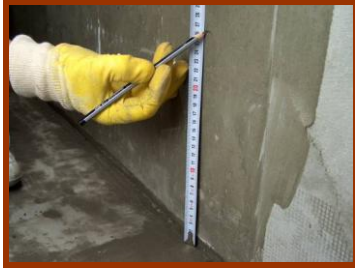
Resim 1.5: Mastar yüksekliğinin bire bir hesaplanması
