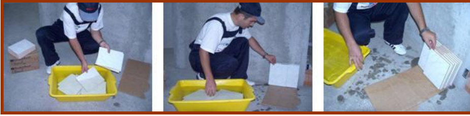
Resim 3.7: Seramik karoların ıslatılması
