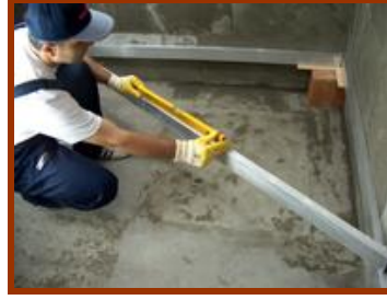
Resim 1.7: Masterın su terazisi ile teraziye alınması
