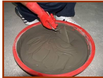
Resim 2.6: Yapıştırma harcının dinlendirilmesi ve tekrar karıştırılması
