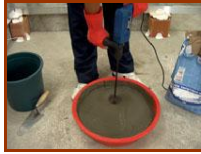
Resim 2.5: Yapıştırma harcının karıştırılması
