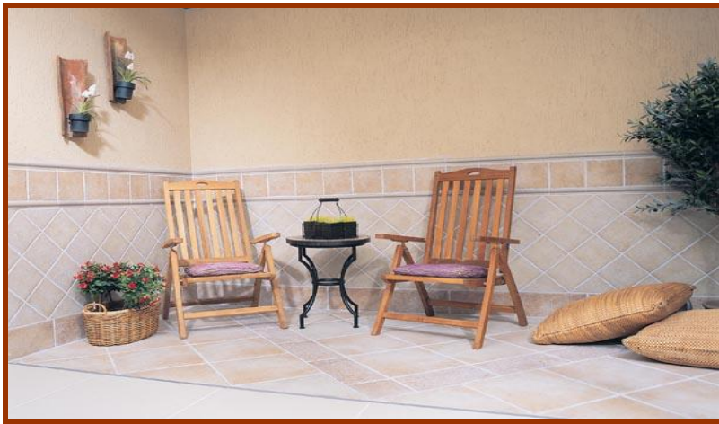
Resim 3.6: Diyagonal duvar kaplaması
