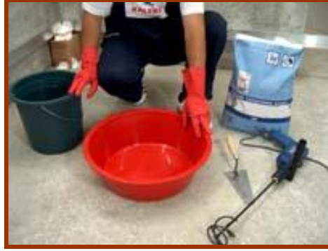
Resim 2.2: Yapıştırma harcı hazırlamada kullanılan alet ve malzemeler
