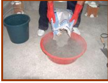
Resim 2.4: Yapıştırma harcına su dökülmesi ve ilk karıştırma
