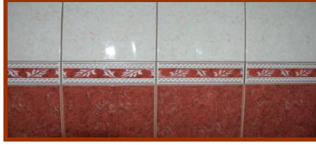
Resim 3.5: Düz (hasır) duvar kaplaması
