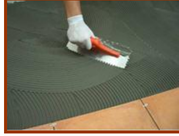
Resim 3.1: Yapıştırma harcının serilmesi ve taraklanması
