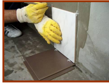
Resim 1.6: Mastar yüksekliğinin ölçü ile hesaplanması
