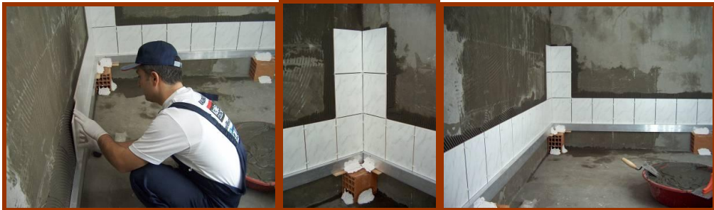
Resim 3.13: İlk sıra ve köşelerin yapılması
