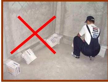
Resim 1.8: Masterların seramik kutularıyla desteklenmesi
