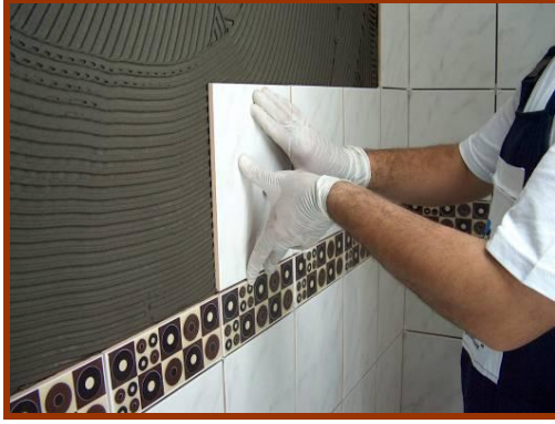
Resim 3.11: Seramik karonun el ile yerleştirilmesi ve tokmaklanması
