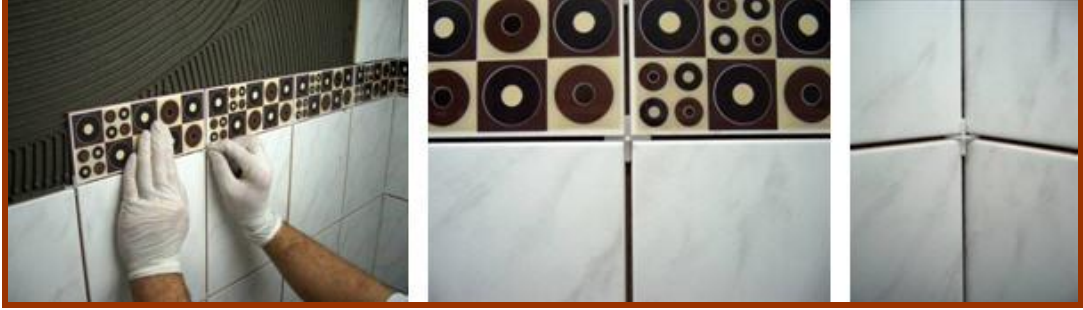
Resim 3.14: Derz artılarının yerleştirilmesi
