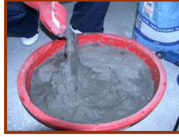
Resim 2.4: Yapıştırma harcına su dökülmesi ve ilk karıştırma
