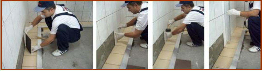
Resim 3.3: Yağlama yöntemi
