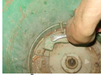
Resim 3.24: Üst baskı plaka kapağının sökülmesi
