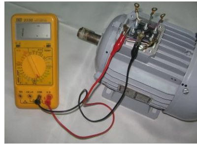
Resim 1.4: Sargılar arası kısa devre kontrolü
